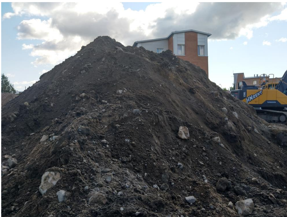
Kuva 2. Pima-työmaalla kaivettua maa-ainesta, joka on läjitetty.
