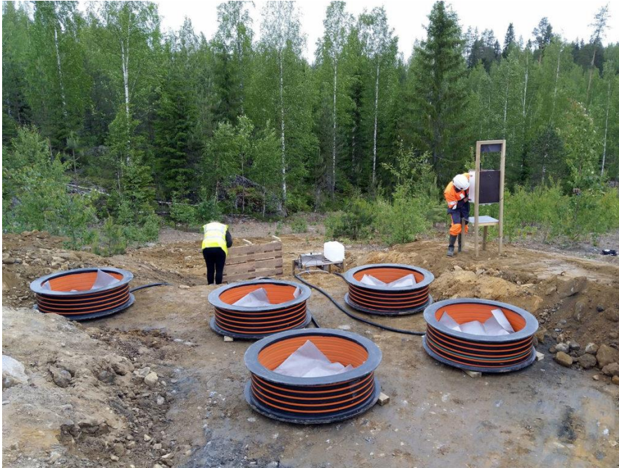
Kuva 6. Lysimetrejä asennetaan paikoilleen tutkimuksia varten. (24.)
