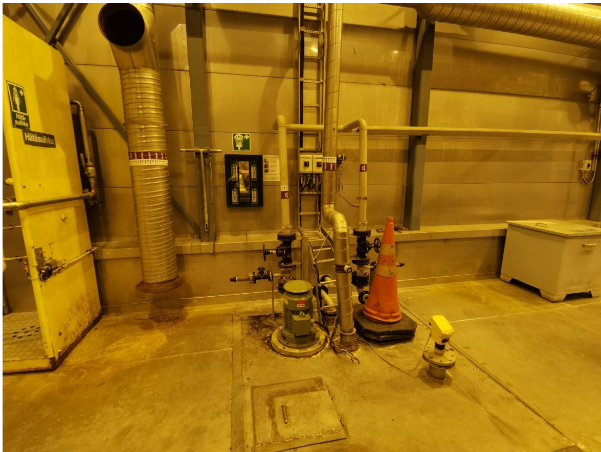
Kuva 25. Purkuaseman vuotokaivon pumppausjärjestelyt
