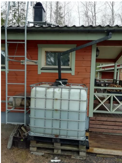
Kuva 9. Hulevesiä voidaan hyötykäyttää esimerkiksi kastelu-, löyly- tai pesuvetenä. Kuva: Jere Lehtonen.
