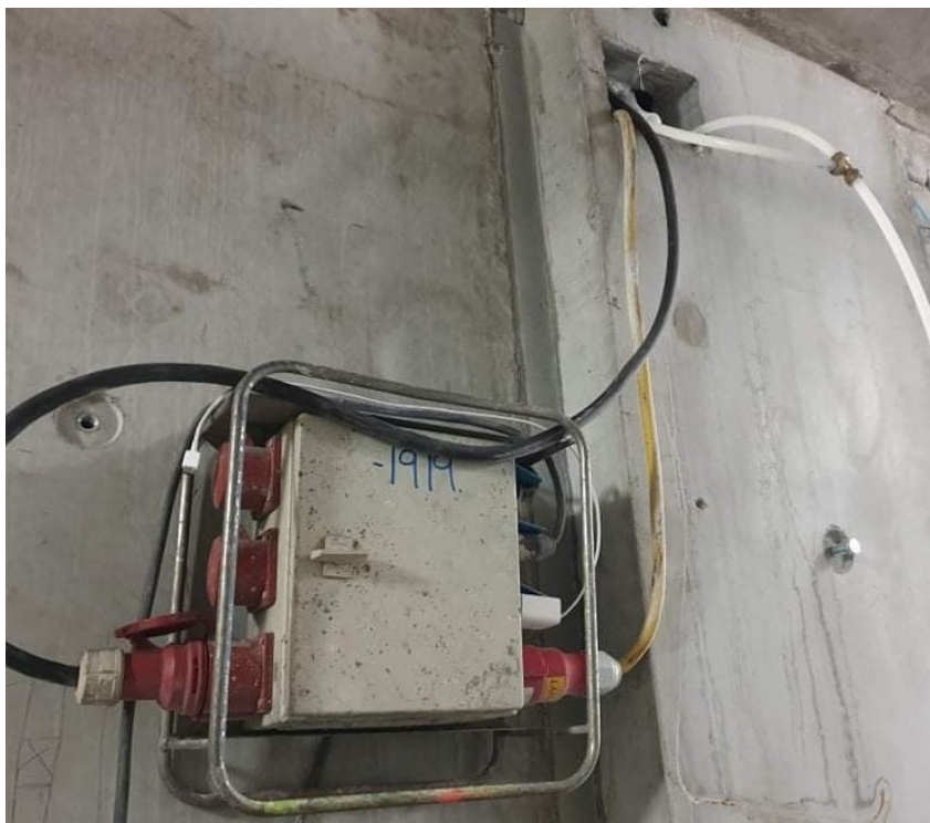
Kuva 6. Sähkövienti elpo-hormia hyödyntäen kokeilussa YIT Vantaan Kurpit- sassa
