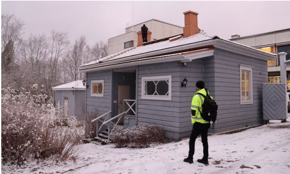
Kuva 3. Paakarintuvan ilmanvaihdon toimintaa selvitettiin myös tutkimalla rakennuksen piippujen ja hormien kunto ja toimivuus (Kuva: Minna Hietanen)
