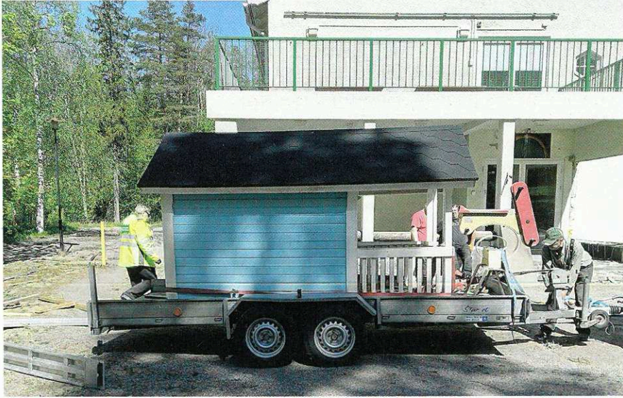
Kuva 1. Leikkimökin nouto suoraan purkukohteesta. Kuva: Markku Raimovaara.
