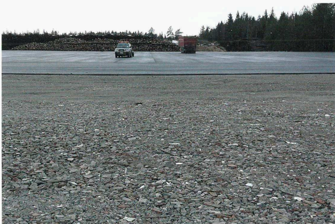
Kuva 4. Biopolttoaineen varastointikentän laajennusosa, jonka maarakenteissa käytettiin murskattua ja seulottua betoni- ja tiilijätettä. Kuva: Markku Raimovaara.
