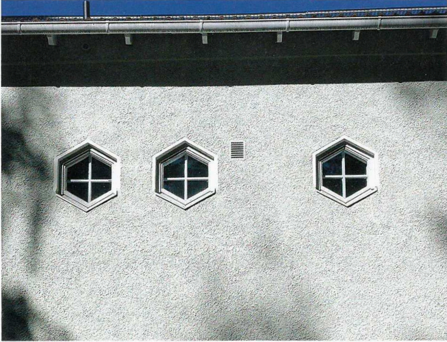
Kuva 2. Kohteen rakennuksissa oli kuusikulmaisia ikkunoita. Kuva: Markku Raimovaara.
