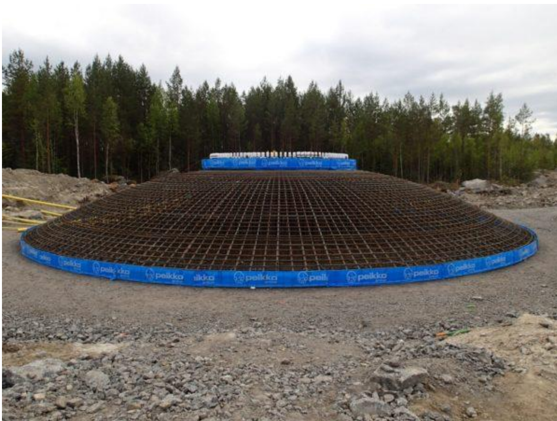
Kuva 8. Kuvassa näkyvät tuulivoimalan perustuksen raudoitteet ennen betonin valamista. [26]
