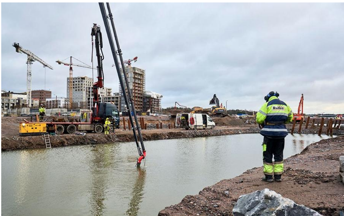
Kuva 7. Helsingissä Sompasaassa vuonna 2018 otetussa kuvassa tehdään vedenalaista valua. [24]
