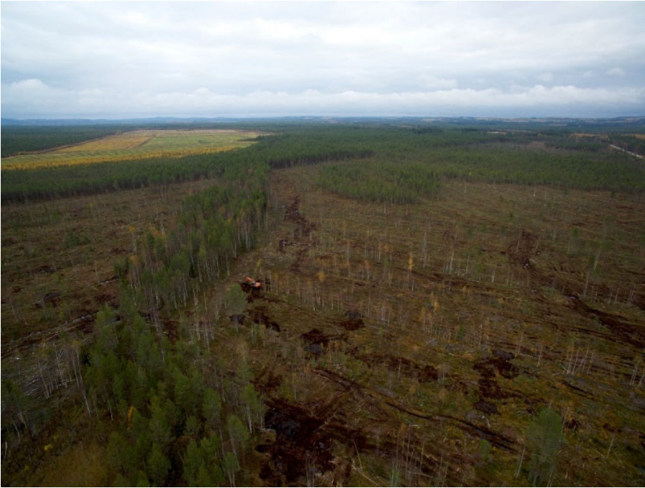
Kuva 8. Aittokorvenlammensuon ("Linnunsuo NORD") ennallistaminen etenee loppukesällä 2020. Kaivinkoneella tukitaan parhaillaan metsäojaa aivan Aittokorvenlammempuron äärellä. Foto: Osuuskunta Lumimuutos.
