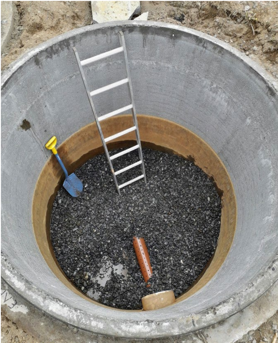
KUVA 4. Kannettomasta ja suodatinmateriaalittomasta kaivosta poistoputken kunto- tarkastus muutostöiden yhteydessä (kuva Aki Mykkänen).
