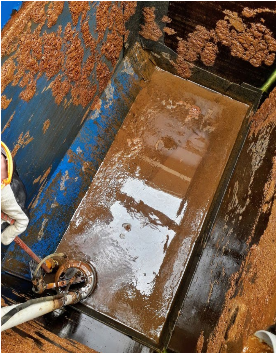
KUVA 4. Tuloltaan pohjalle kolmen kuukauden aikana muodostunutta rautasakkaa altaan tyhjennyksen aikana (kuva Aki Mykkänen).
