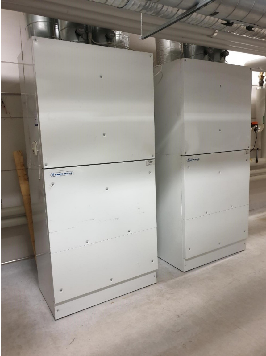
Kuva 1. Vanha järjestelmä. Kaksi kappaletta Ilmava 252D- ilmanvaihtokoneita IV-konehuoneessa Valloxin Loimaan tehtaalla.
