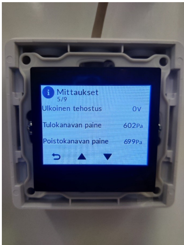
Kuva 20. Pureon kanavapaine mitoitusilmavirralla.
