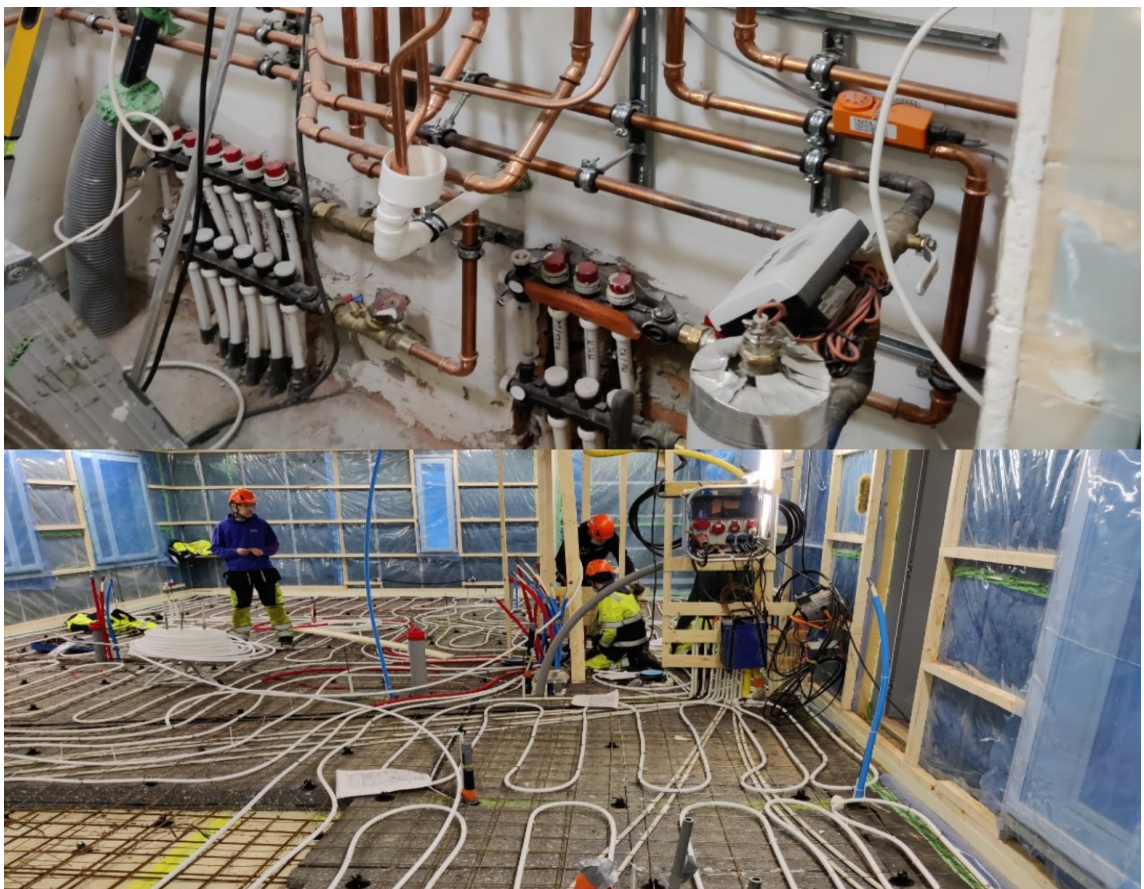
Kuva 3. OSAO Kivikkokankaan opetustyömaan lvi-asennustyöt. Syksy 2020.
