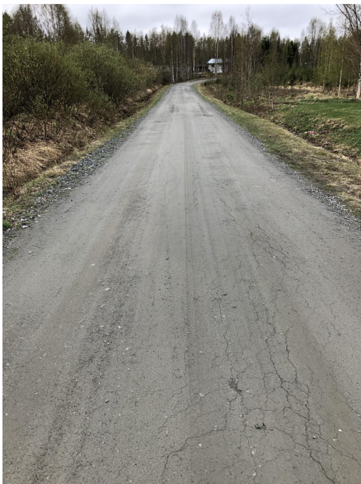
Kuva 4. Tie suodatinkankaan ja murskeen lisäyksen jälkeen (Keränen 2021.)
