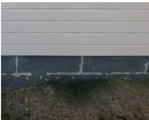
KUVA 1. Rakennuksen maalattu harkkosokkeli
