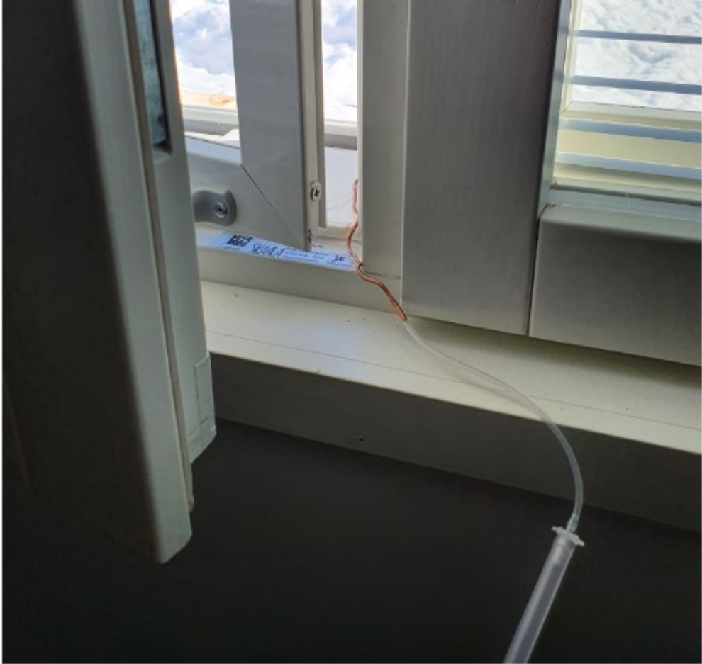
Kuva 9. Kuparikaapilaariputken vienti ulos tuuletusikkunan alareunasta
