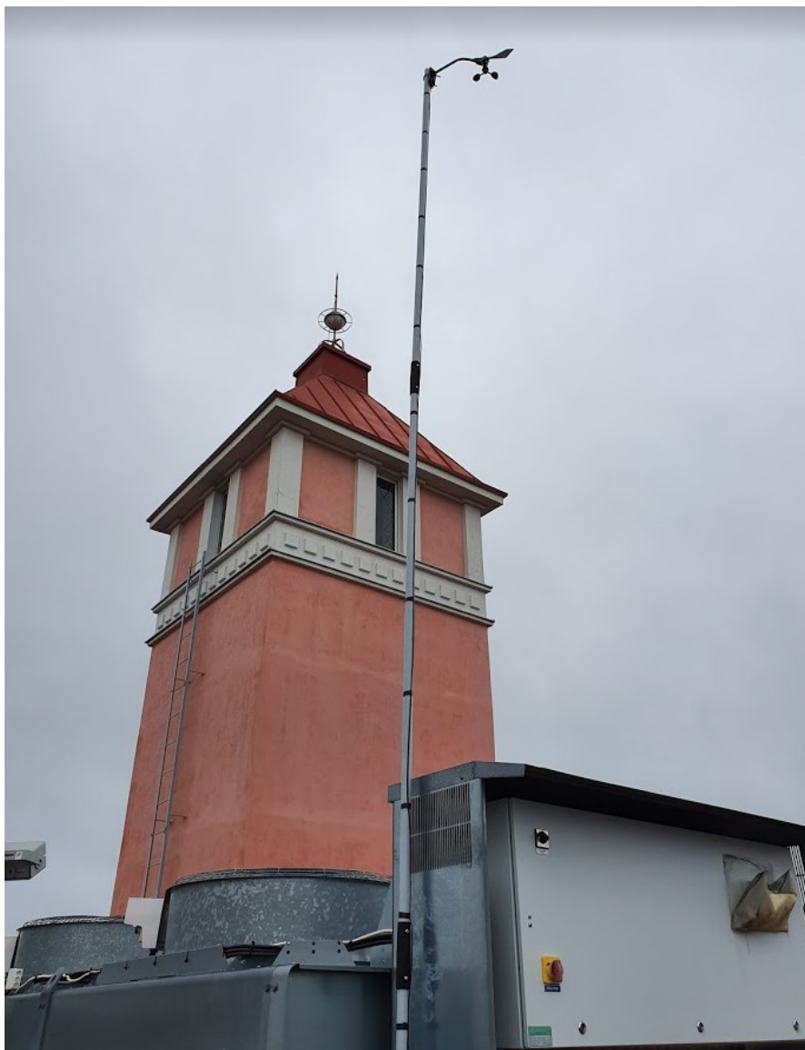
Kuva 28. Tuulianturi rakennuksen katolle asennettuna.
