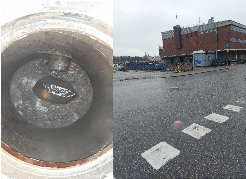
Kuvio 7, Valokuva kaivon sisältä ja yleisvalokuva.
