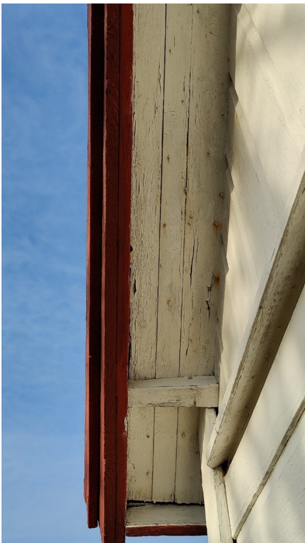
Figur 93 Täckan ovanför ytterdörren (Isaksson 2021)
