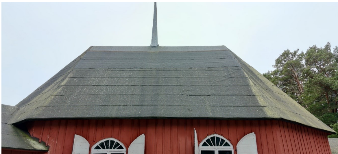
Figur 33 Taket på norra sidan (Isaksson 2021)
