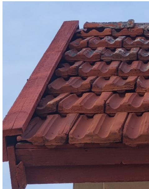
Figur 90 Vattbrädet på sydvästra sidan (Isaksson 2021)
