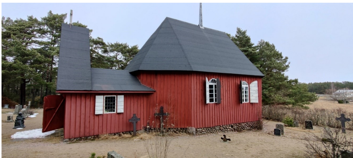
Figur 34 Taket på södra sidan (Isaksson 2021)
