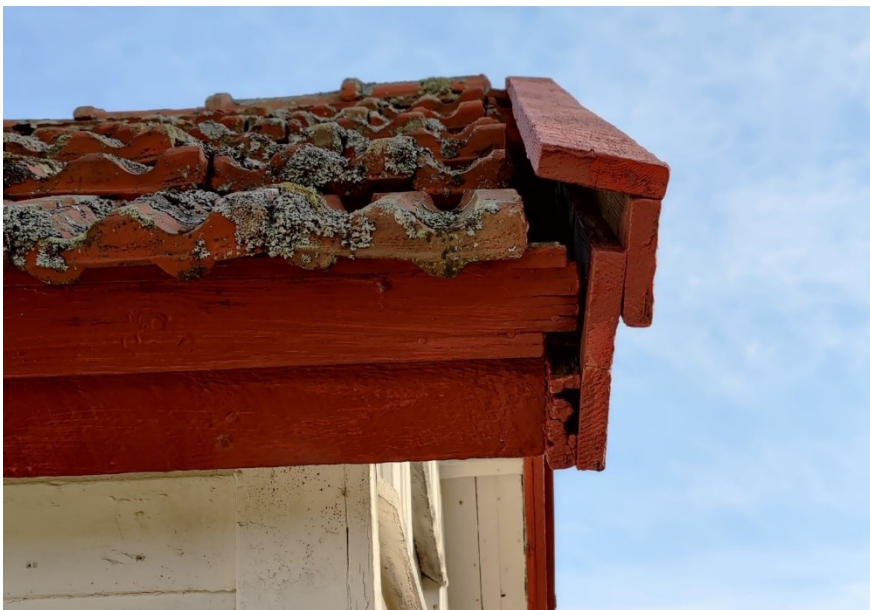
Figur 92 Vattbrädet på farstutaket (Isaksson 2021)
