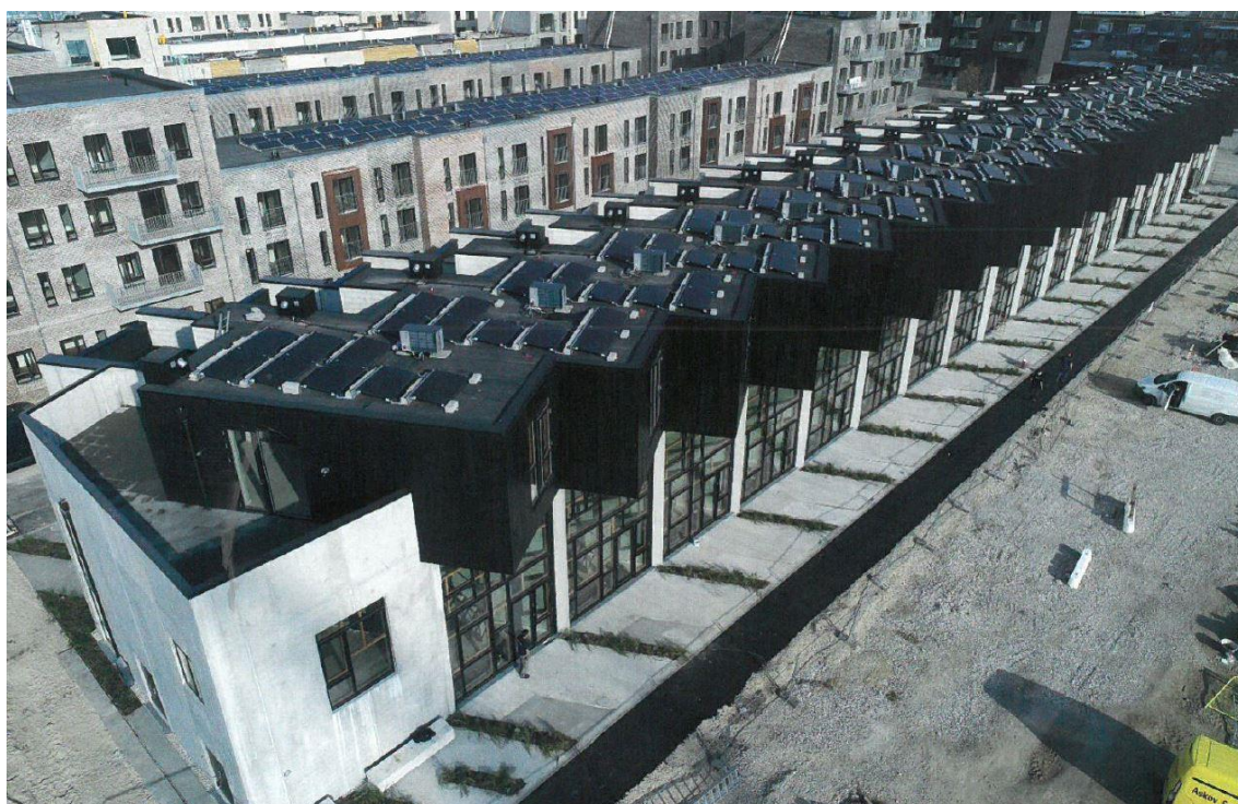
Kuva 6. Huoneistojen katoille on asennettu aurinkopaneelit, joilla käyttäjien omavaraisuusaste paranee (Koivisto, 2020).
