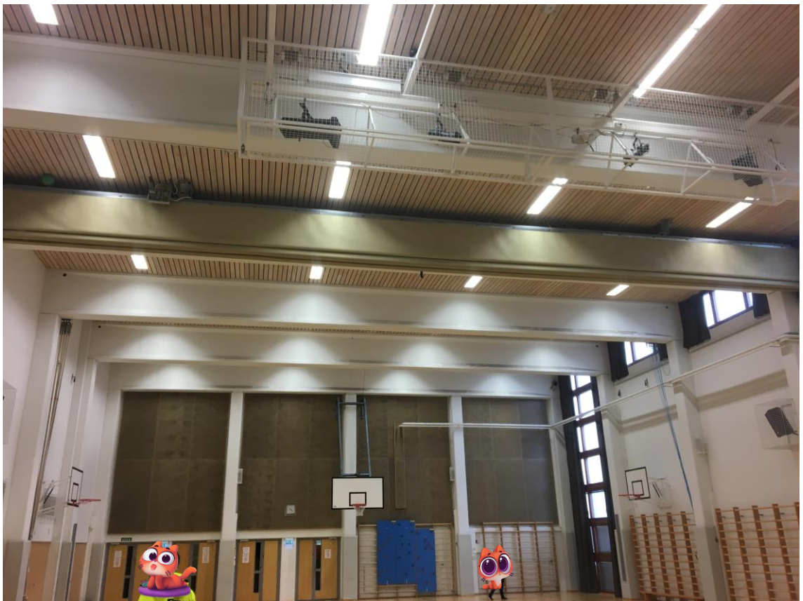
Kuva 22. Maatullin ala-asteen koulun liikuntasalin pilareja ja palkkeja (kuvassa esiintyvät henkilöt sensuroitu yksityisyyden suojaamiseksi) (Pitkänen, 2020-2021).
