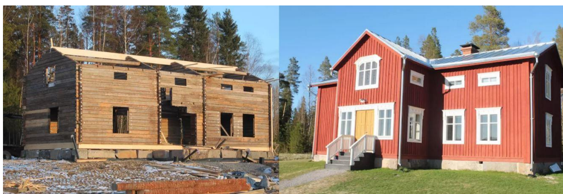
Kuva 8. Närpiöstä Seinäjoelle siirretty 170-vuotias hirsitalo ennen ja jälkeen siirron (Leiwo, 2017).
