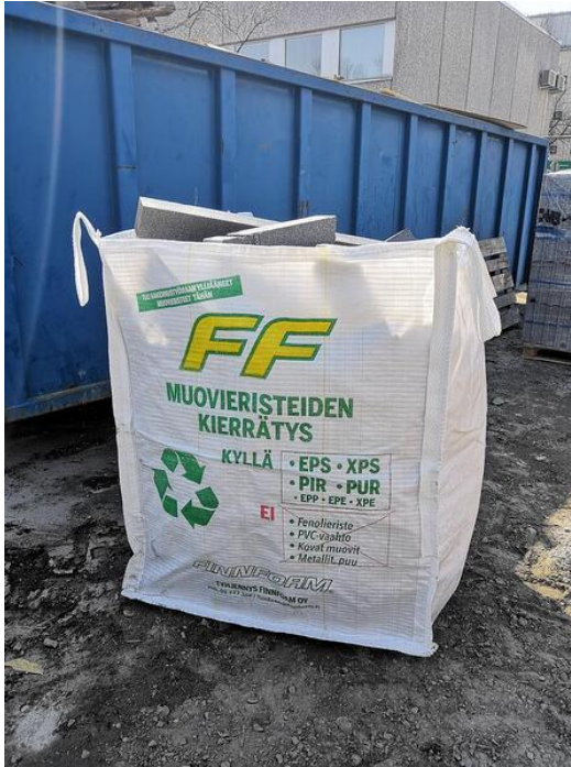
Kuva 12. Muovieristejätteen keräyssäkki työmaalla (L&T, 2020).
