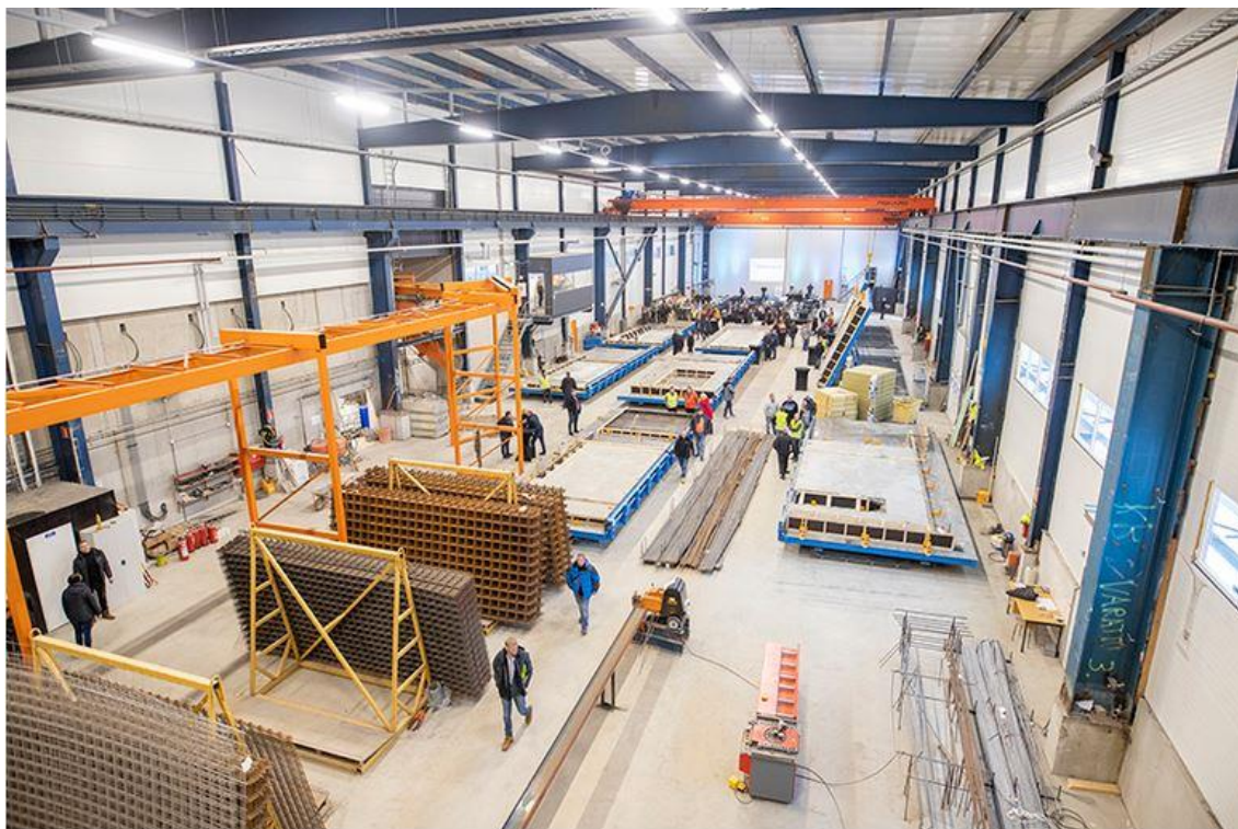
Kuva 7. Kestobetonin uusi Lahden tehdashalli, jossa on hyödynnetty Merihallin pilareita ja palkkeja (Projektiutiset, 2019).
