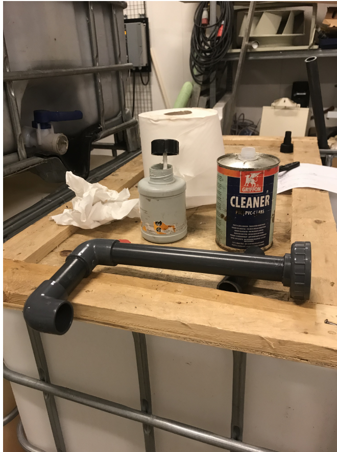
Figur 6. Limning av pvc-rör
