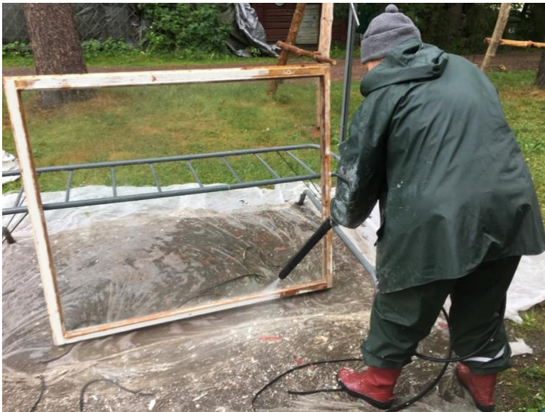
Kuva 18. Maalaus pohjien puhdistus painepesurilla
