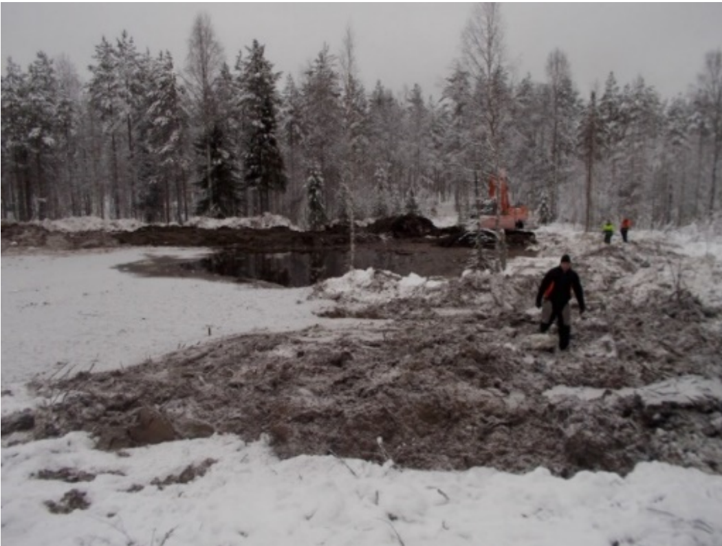
Kuva 20. Aivan Kissapuron latvoilla sijaitsevan Vehkasuon kosteikon rakennustyö etenee 26.01.2017. Lähinnä kameraa vesistökunnostusyrittäjä, työstä vastaava Janne Raassina.
