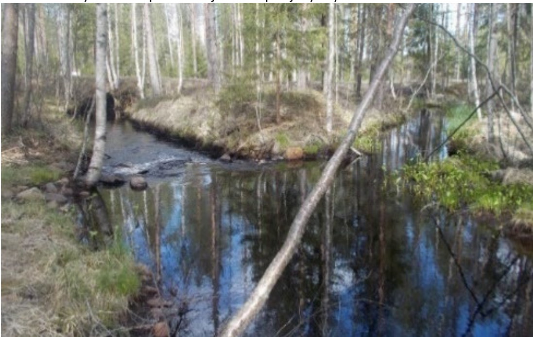
Kuva 15. Kissapuro alittaa Kissapurontien 02.06.2020. Vasen uoma on uittoa varten kaivettu, ja siihen on kesällä 2016 rakennettu pohjakynnys. Kynnyksen ansiosta osa Kissapuron vedestä kääntyy oikeanpuoleiseen luontaiseen mutkittelevaan eli meanderoivaan uomaan. Luontaiselle uomalle on rakennettu myös rumpu Kissapurontien ali.
