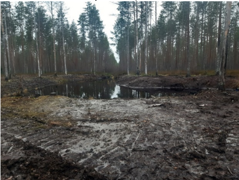
Kuva 12. Kissapuron alajuoksulle syksyllä 2015 kaivettu metsäojitusalueen laskeutusallas. Se laskee vetensä ja ainevirtaamansa kuvassa 13 esitettyyn laskeutusaltaaseen, joka laskee välittömästi Kissapuroon.
