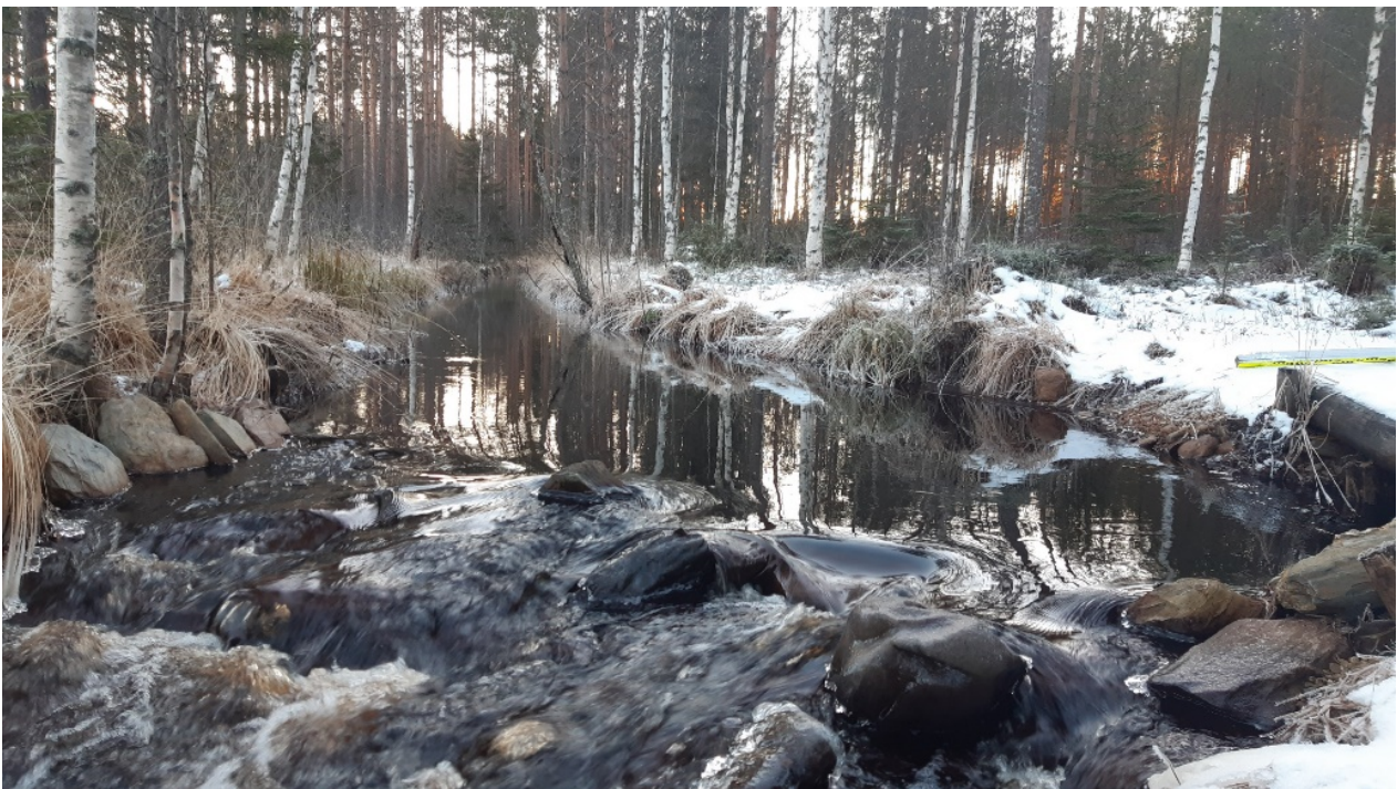
Näkymä Kissapuron alajuoksulle rakennetusta pohjakynnyksestä 08.12.2020
