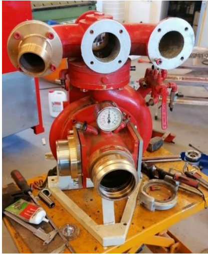
Kuva 8 Esteri D-240- palopumppu huollettuna ennen maalausta
