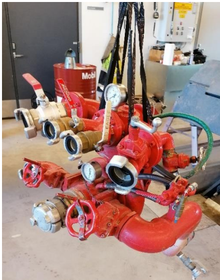
Kuva 7 Palopumppu ennen kunnostusta
