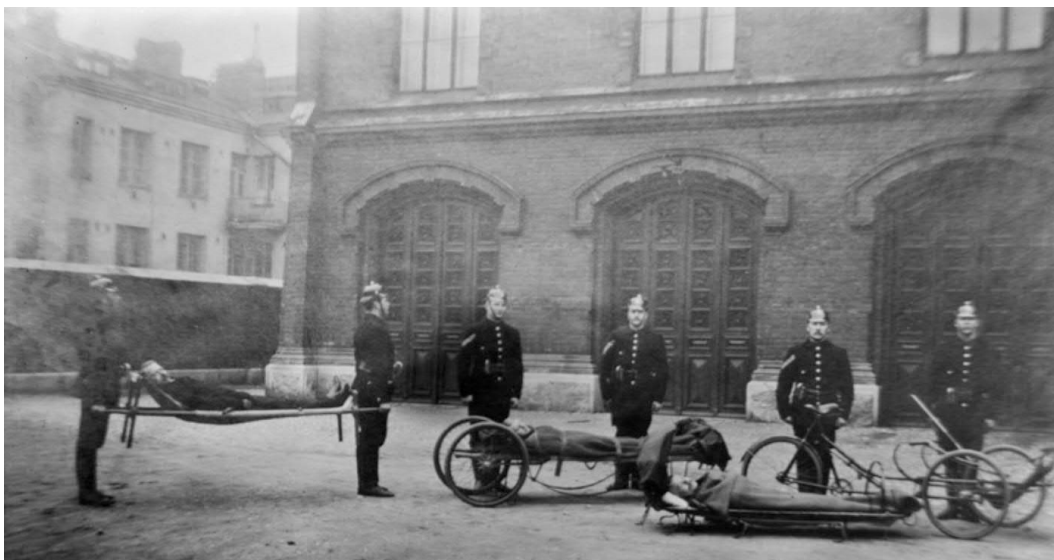
Kuva 4. Sairaankuljetuskalustoa pääpaloaseman pihalla 1907 Korkeavuorenkatu 26. Oikealla polkupyöräparit. Kuvan tekijä Helsingin kaupungin palolaitos. Kuva vapaasti käytettävissä verkkosivulta Helsinkikuvia.fi .
