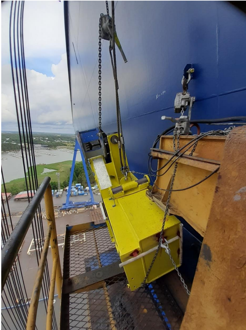
Kuva 13. Uuden telin asennus.
