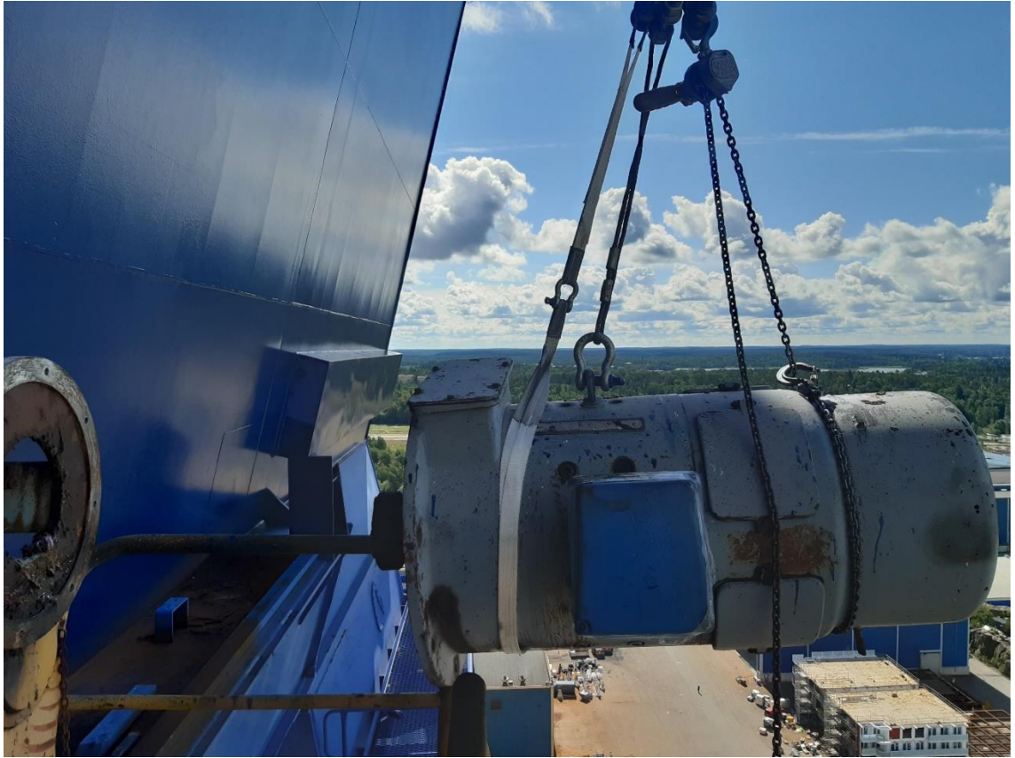
Kuva 9. Sähkömoottorin irrotus.
