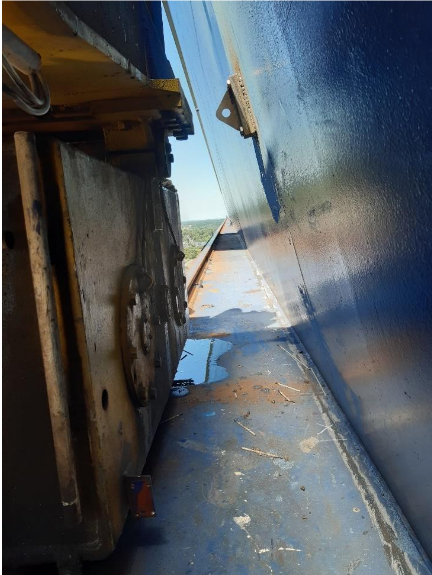
Kuva 7. Nostokorva telin taljaukseen.
