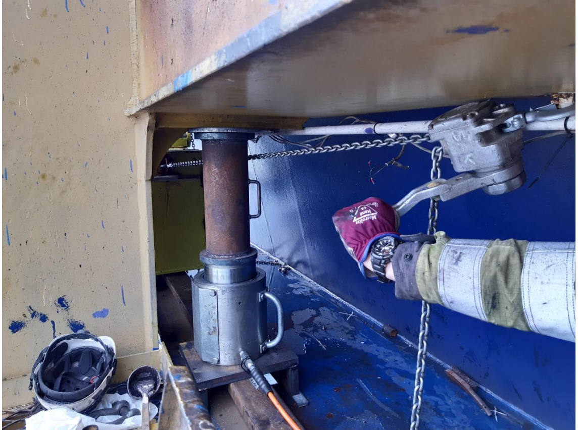
Kuva 14. Telin taljausta vaunun päätykannattajan alle.
