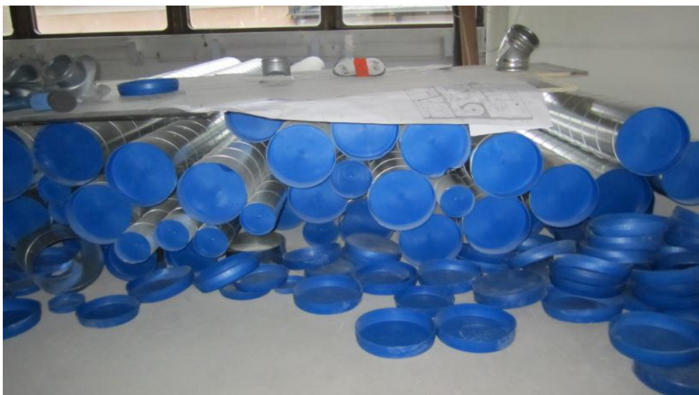
Kuva 10. Välivarastossa olevissa ilmanvaihtokanavissa on oltava aina tulpat päissä [9].
