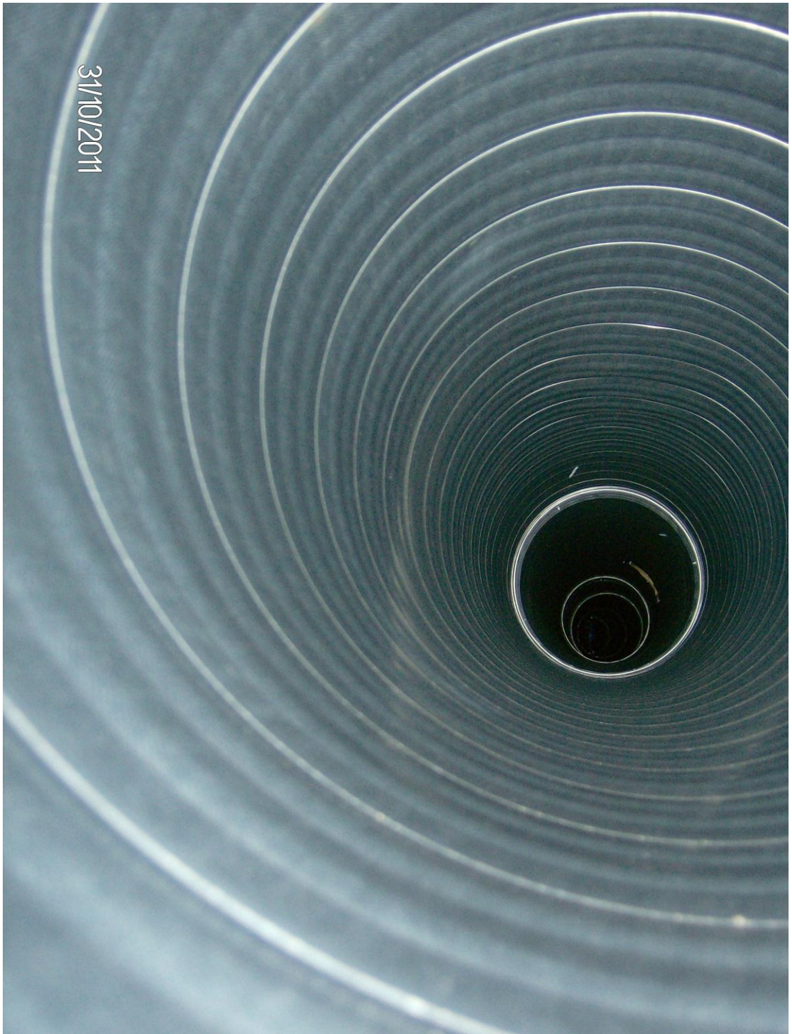
Kuva 16. Sisältä kuvattu pyöreä kanava näyttää olevan myös puhdas. Tämä kuva on otettu Kaisa-talon työmaalta Helsingistä. [8]
