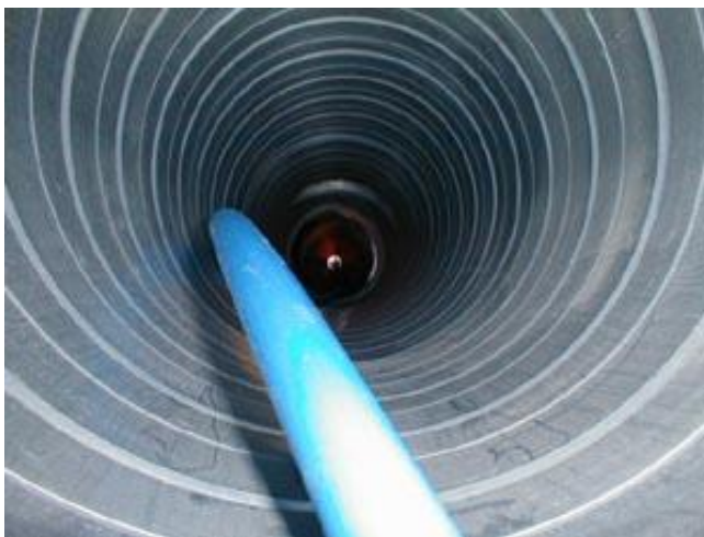
Kuva 3. Puhdistettu ilmanvaihtokanava [3]
