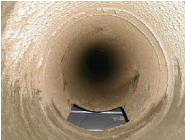
Kuva 2. Likainen ilmanvaihtokanava [3]
