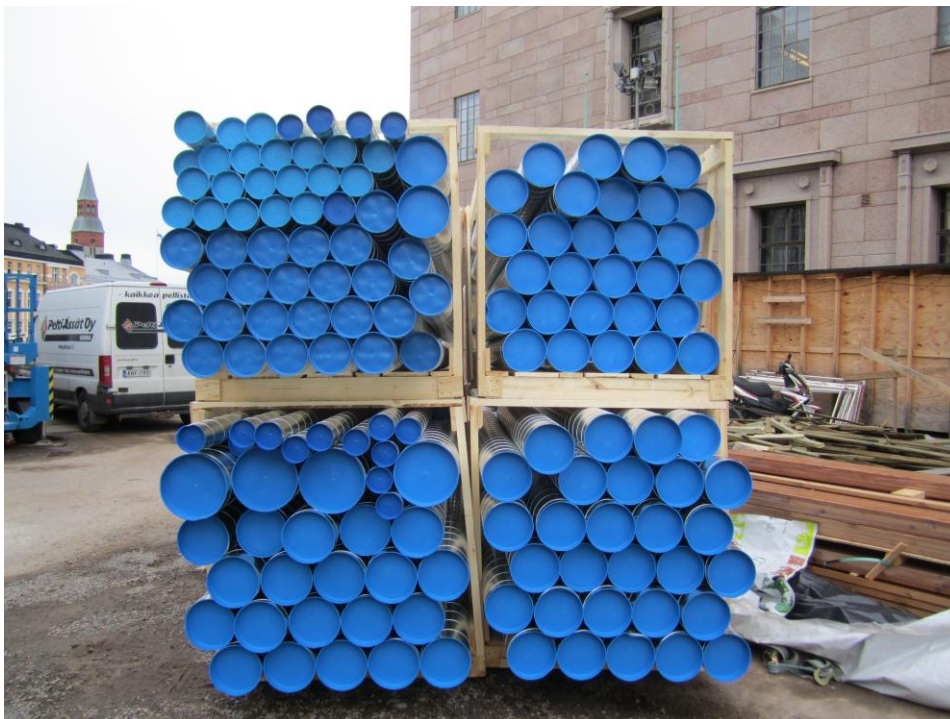
Kuva 8. Juuri työmaalle tullutta ilmanvaihtokanavaa, jotka ovat oikein tulpattuja ja kuljetushäkkeissä [9].
