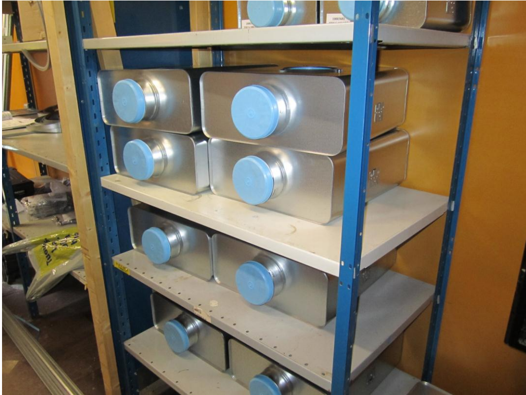
Kuva 11. Välivarastossa olevissa tuloilmalaatikoissa on oltava aina tulpat päissä [9].
