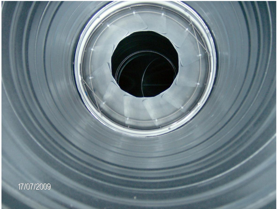
Kuva 18. Sisältä kuvattu pyöreä kanava näyttää puhtaalta ja samoin siinä oleva säätöpelti. Tämä kuva on otettu TKK Fysiikka -työmaalta. [8]
