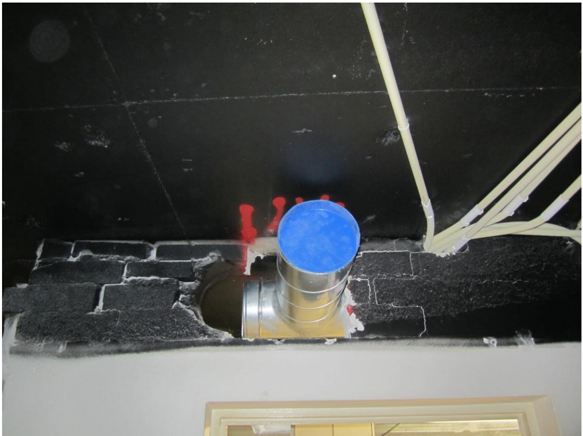
Kuva 13. Ilmanvaihtokanavien päät on aina tulpattava, kun asennustyö ei ole käynnissä [9].
