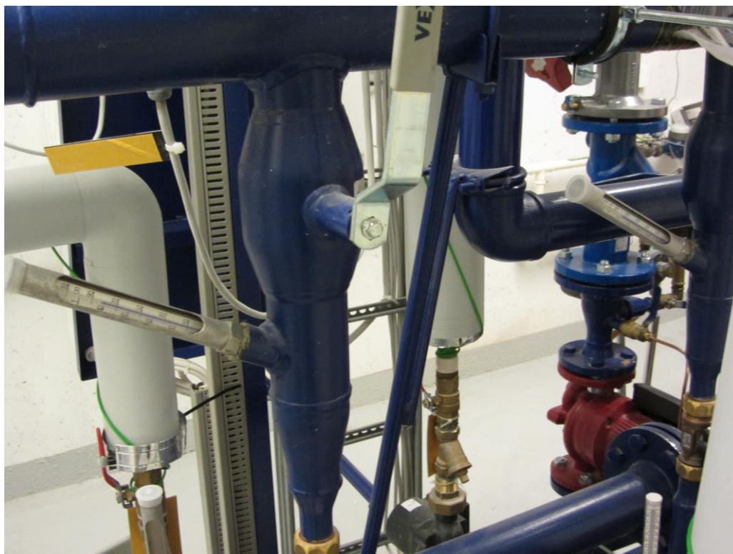
Kuva 10. Mittaukset kiertovesiputkissa (kuva Aino Pelto-Huikko, Prizztech, 2012)
