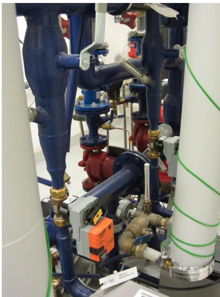
Kuva 9. Mittaus PEX-putkesta (kuva Aino Pelto-Huikko, Prizztech, 2012)
