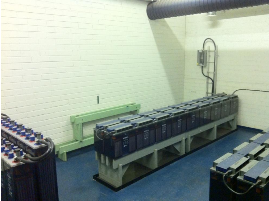
KUVA 6. Nsl2:n oikea akkuhuone, jossa sijaitsevat 2EC22 220 V:n akusto sekä 2EF 23 +26 V:n akusto.
