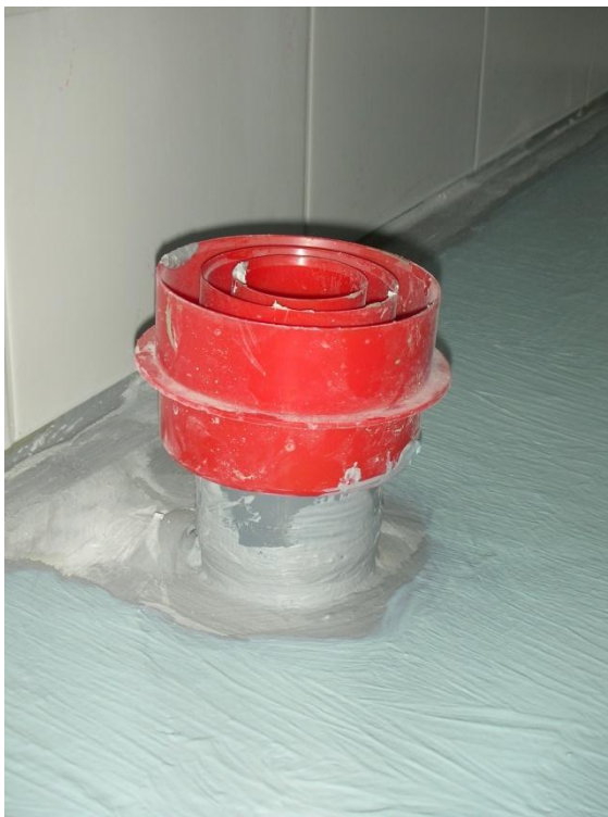
KUVA 8. Vessanpöntön läpivienti.
