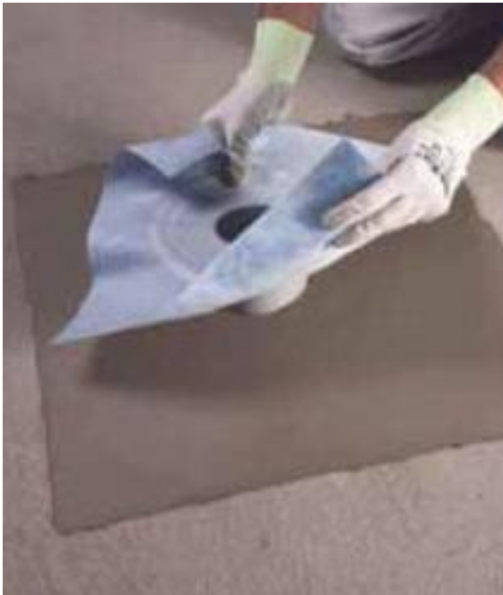
KUVA 2. Mapelastic-vedeneristeeseen lattiakaivokappaleen asennus.
