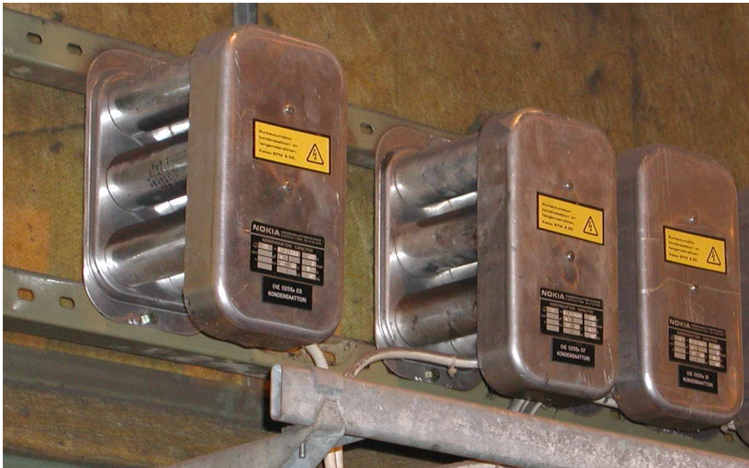
KUVIO 16. Valaistuskeskuksen kondensaattoreita.
