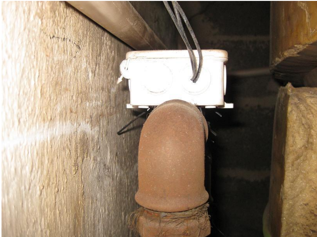
Kuva 19. Lämpötila-anturi asennettuna
