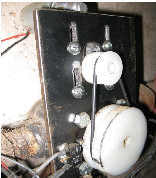
Kuva 18. Automaattisuntti asennettuna
