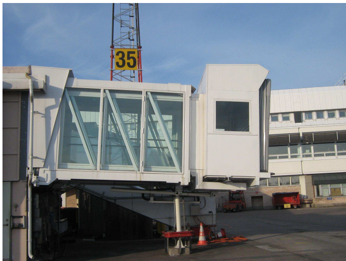
Kuva 39 Valmiiksi asennettu NL- matkustajasilta
