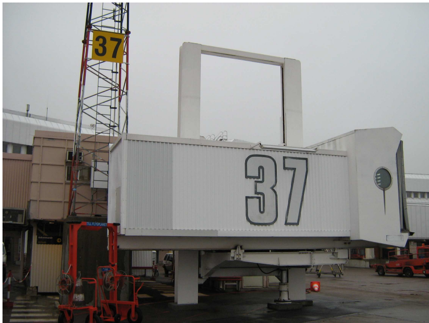
Kuva 31 Arlandan vanha t-silta. Nostokelkan päällä iikkuvatunneli liikkuu ja telakoituu lentokonetta vasten.
