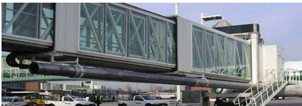
Kuva 46 PCA:n komposiittivalmisteinen teleskooppiputki
