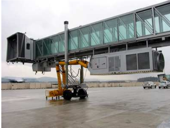
Kuva 47 PCA yksikkö asennettuna sillan alle
