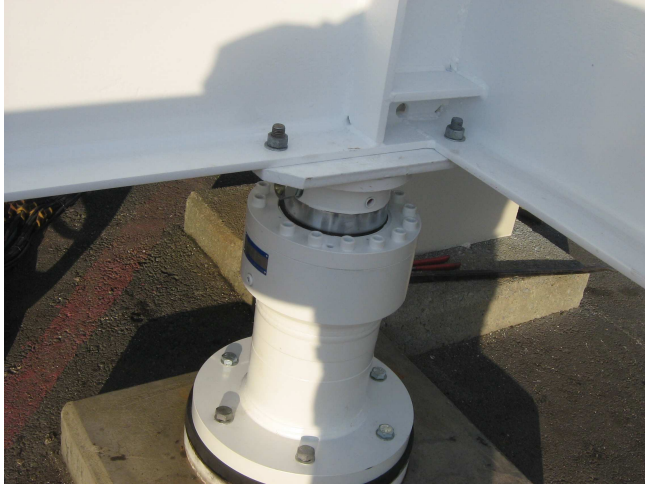
Kuva 32 Uppomäntä sylinteri asennettuna.
