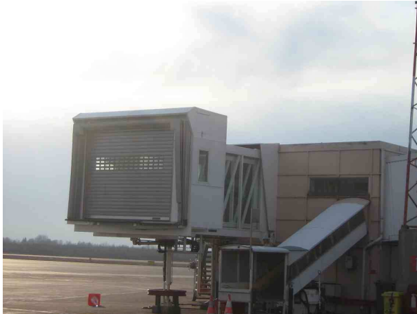
Kuva 18 NL-sillan telakointiosa ulkoa
