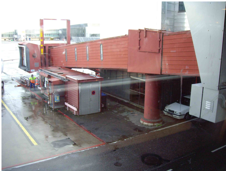
Kuva 11 T-silta, Arlandan lentokentältä
