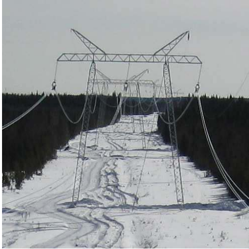
Kuva 3. 400 kV:n kannatuspylväs KI-PT-voimajohdolla
