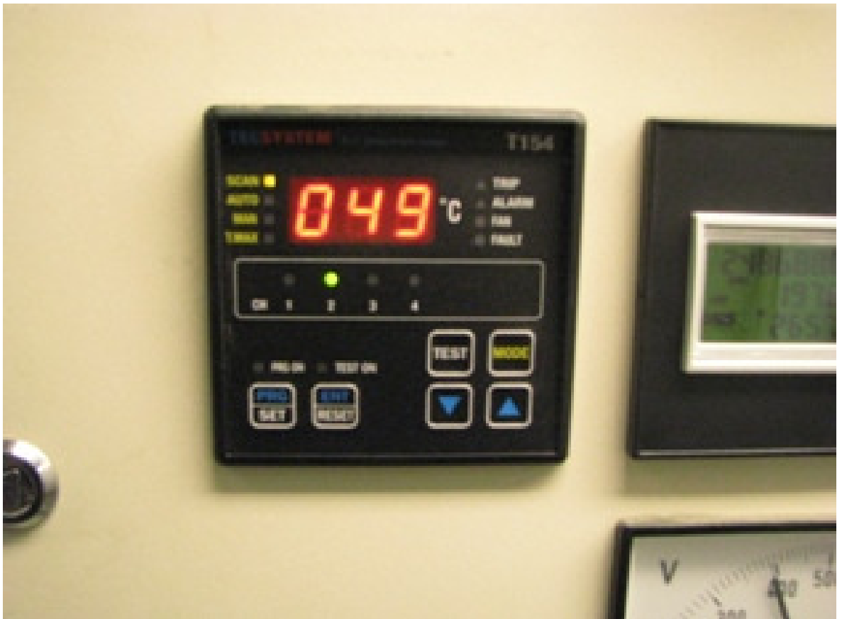
Kuva 9. Lämpötilan valvontayksikkö T154
