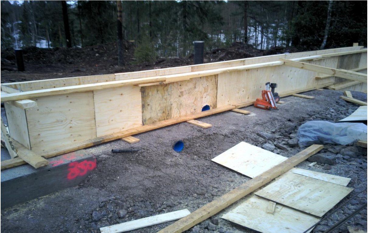
Kuva 15. Sokkelin läpivienti muotissa. Imurijärjestelmän käyttöön tuleva läpivienti on kuvassa oikeanpuolimmainen varaus.
