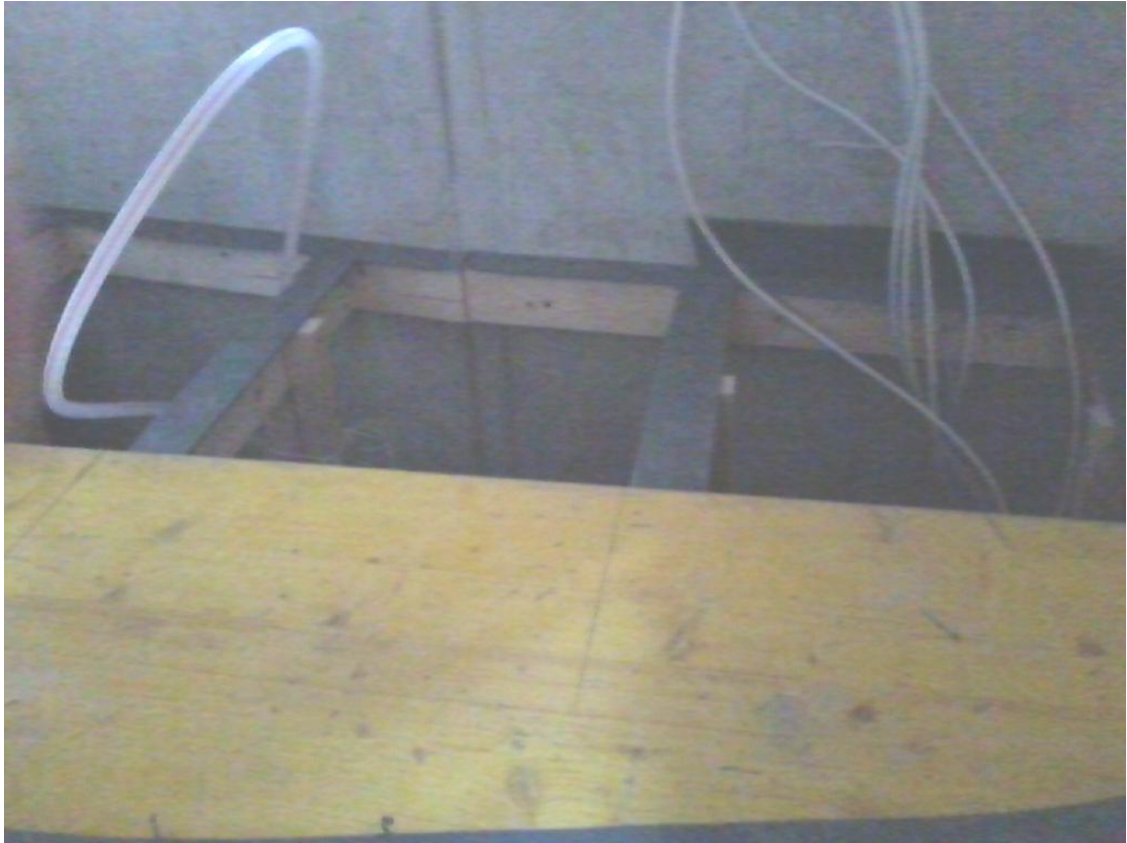
Kuvio 8. Korokelattia rakennusvaiheessa
