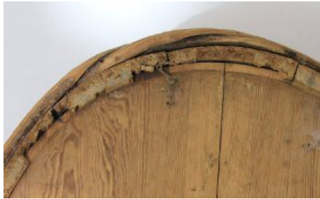
Kuva 41: Uurrevaurio lähemmässä tarkastelussa (Rajamäki 2012)
