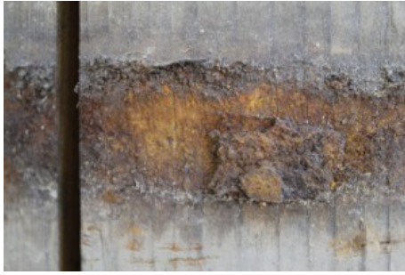
Kuva 54: Vanteen alla ollut puupinta ennen puhdistusta (Rajamäki 2012).
