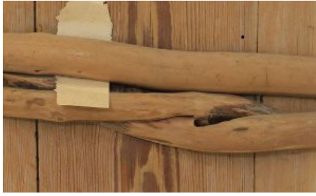
Kuva 34: Vanteen päät on kiinnitetty tosiinsa kynsillä ja taivutettu toistensa alle (Rajamäki 2012).
