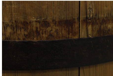
Kuva 55: Vanteen alla ollut puupinta puhdistuksen jälkeen (Rajamäki 2012).
