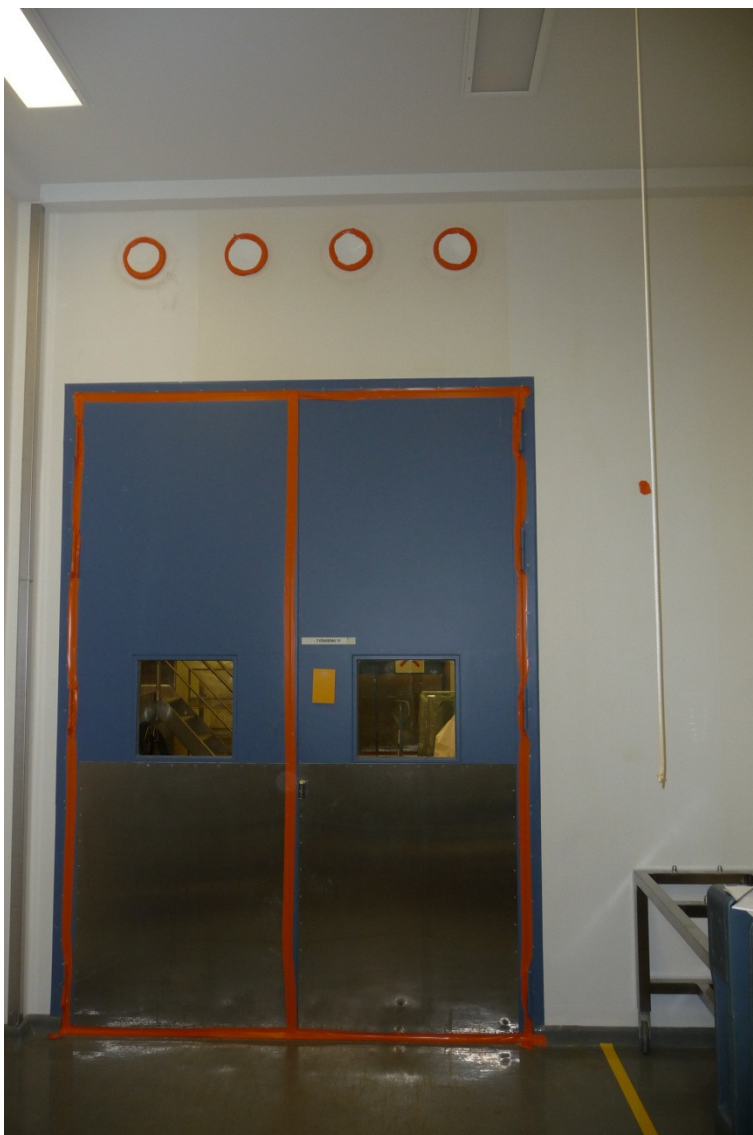
Kuva 2. Tilojen 31108 ja 31109 välinen ovi, siirtoilma venttiilit ja paine-eron mittausreikä teipattuina.
