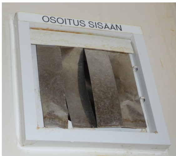
Kuva 3. Painesuhteen indikointiaukko, jossa ilmavirtauksen suunnan osoittavat liikkuvat säleät.
