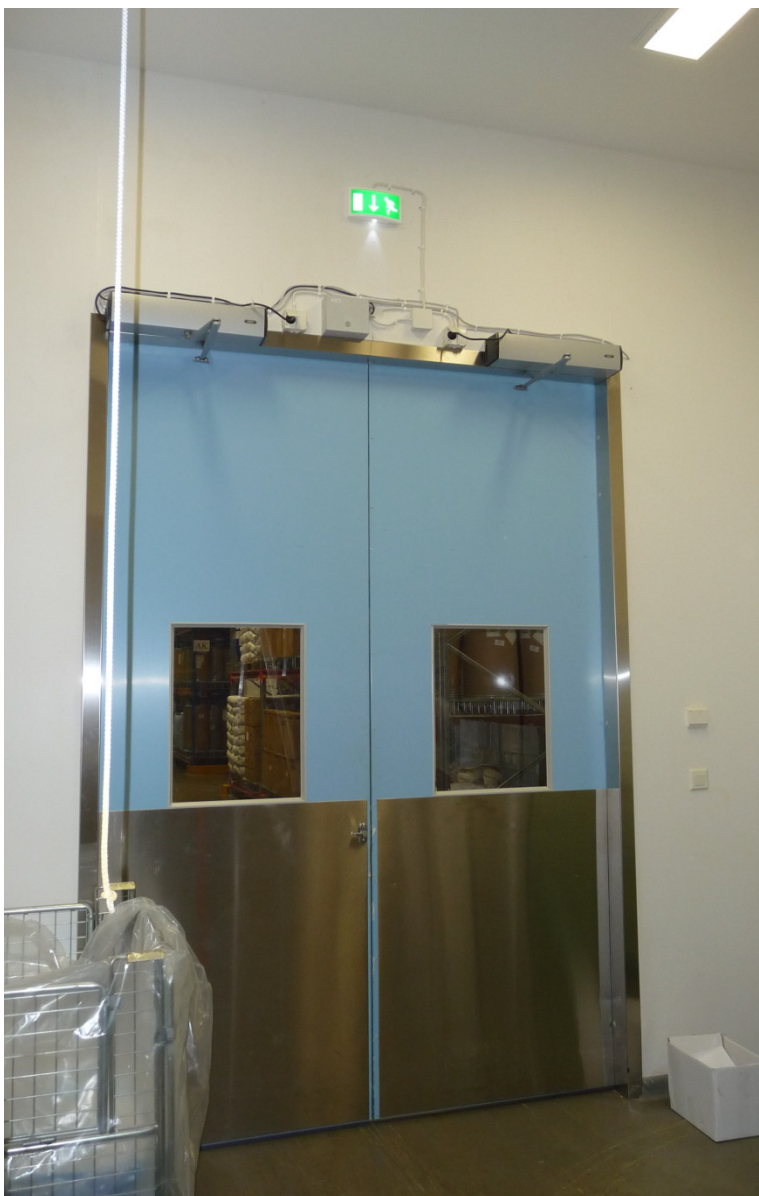
Kuva 3. Tarkasteltava ovi tilojen 31109 ja 31105 välillä.
