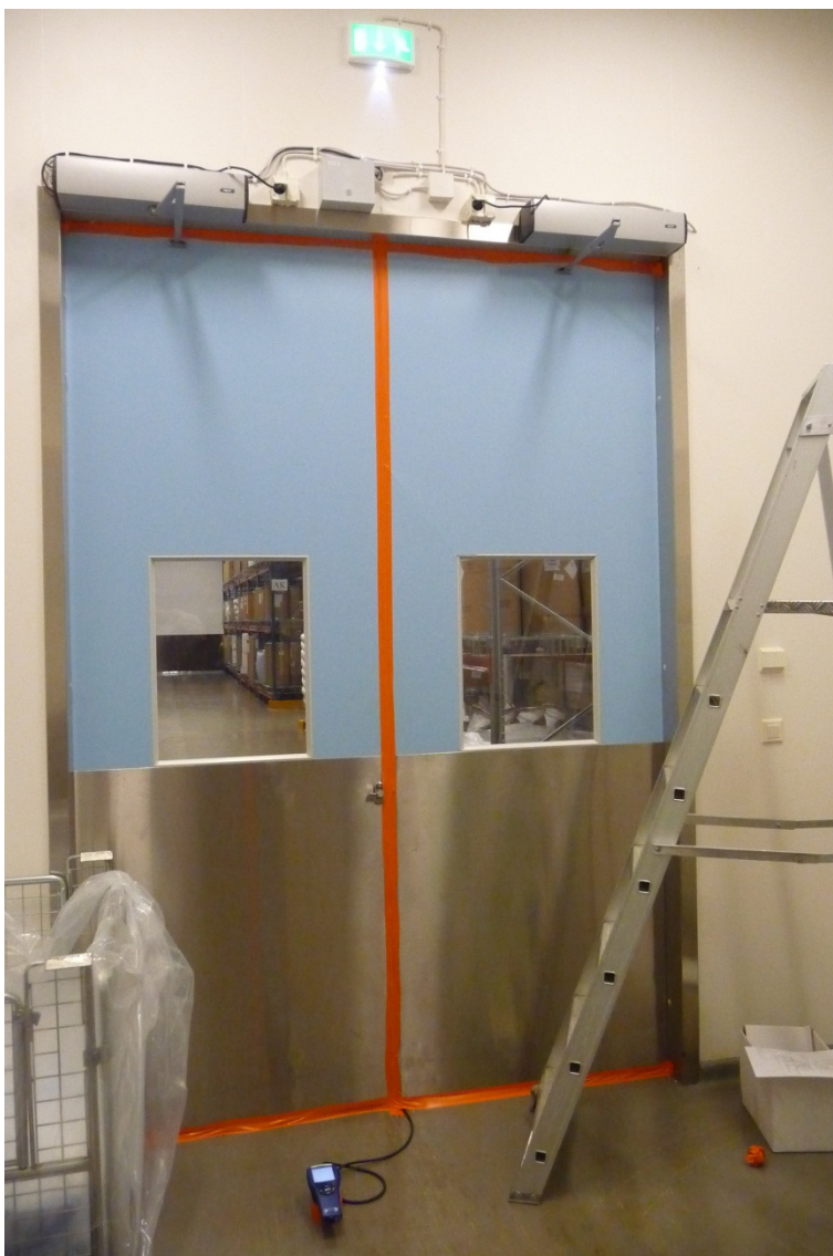
Kuva 5. Tarkasteltava ovi kiinni teipattuna.
