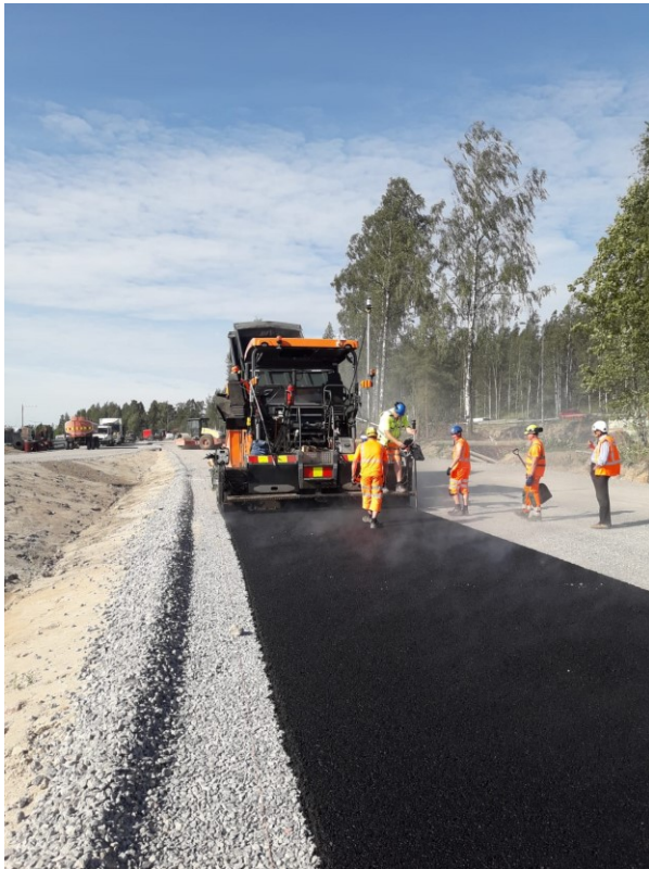
KUVA 12 Mittamies seuraa levitettävän päällysteen korkoa
