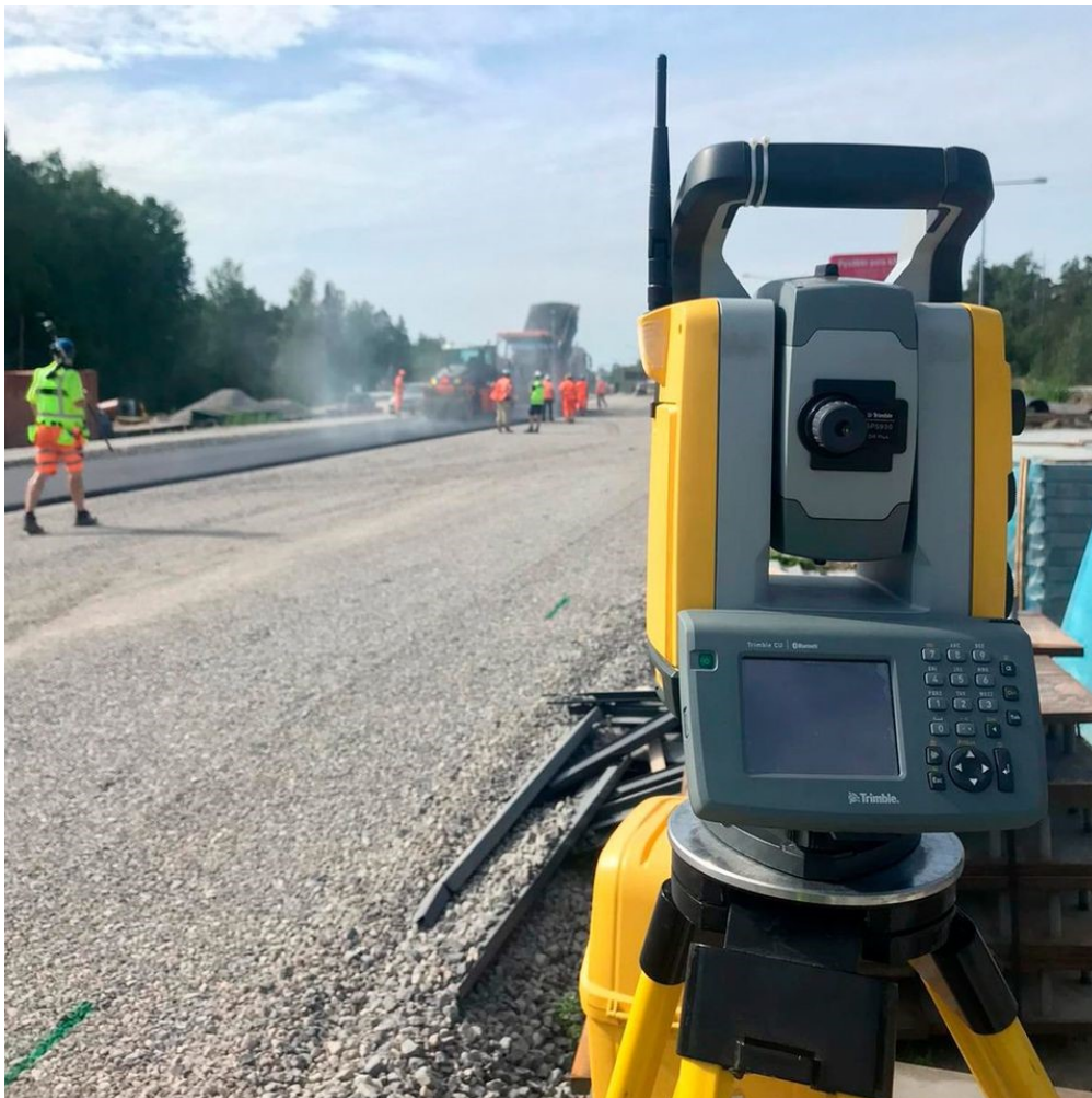
KUVA 13 Näkymä jälkimmäisen ohjaavan takymetrin takana
