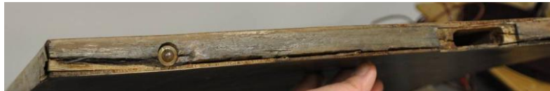
Kuva 19. Etuluukun yläosa oli ennen restaurointia epäsiistin näköinen. (Kangaskolkka 2012)
