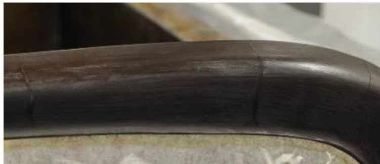
Kuva 34. Lastulevyn eläminen halkaisi grundin myös toisella yrittämällä. (Kangaskolka 2012)
