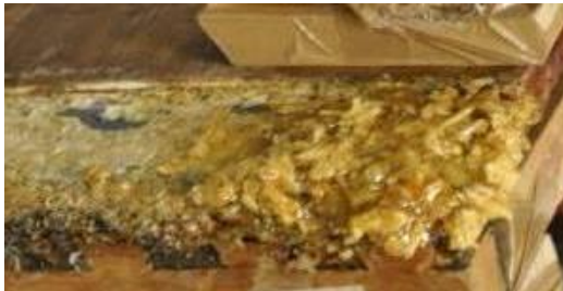
Kuva 26. Puuttuvat alueet täydennettiin lastulevyrouhe-liimaseoksella.
