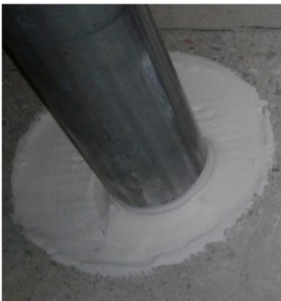
Kuva 2. Akryylipohjainen massa metalliputken palokatkona (Palokatko-opas 2019, 19).
