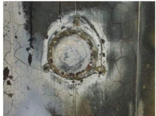
Kuva 5. Palomansetti ennen ja jälkeen tulipalon (Palokatko-opas 2019, 22).
