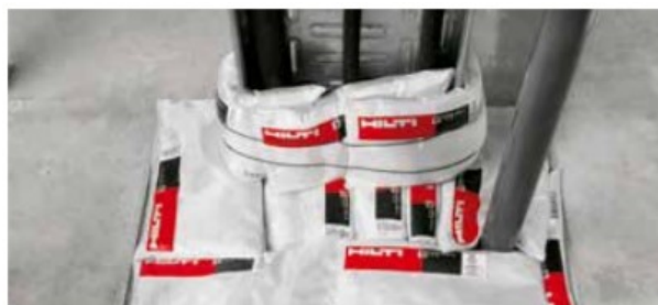
Kuva 8. Hilti CFS-CU palokatkotyyny väliaikaisena tai pysyvänä palokatkona (Hilti palokatkotyyny 2011, 2).
