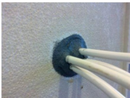
Kuva 4. Grafiittipohjainen palokatkomassa (Palokatko-opas 2019, 20).
