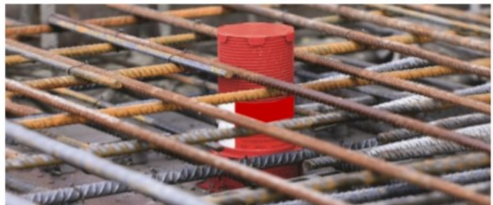
Kuva 9. Esimerkki esivalmistettujen palokatkotuotteiden käytöstä (Palokatko-opas 2019, 24).
