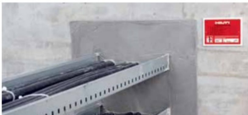
Kuva 3. Hilti CFS-M RG-sementtipohjainen palokatkomassa kaapelikourujen palokatkona (Hilti palokatkomassa 2012, 2).
