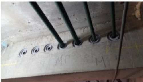
Kuva 9. Esimerkki esivalmistettujen palokatkotuotteiden käytöstä (Palokatko-opas 2019, 24).
