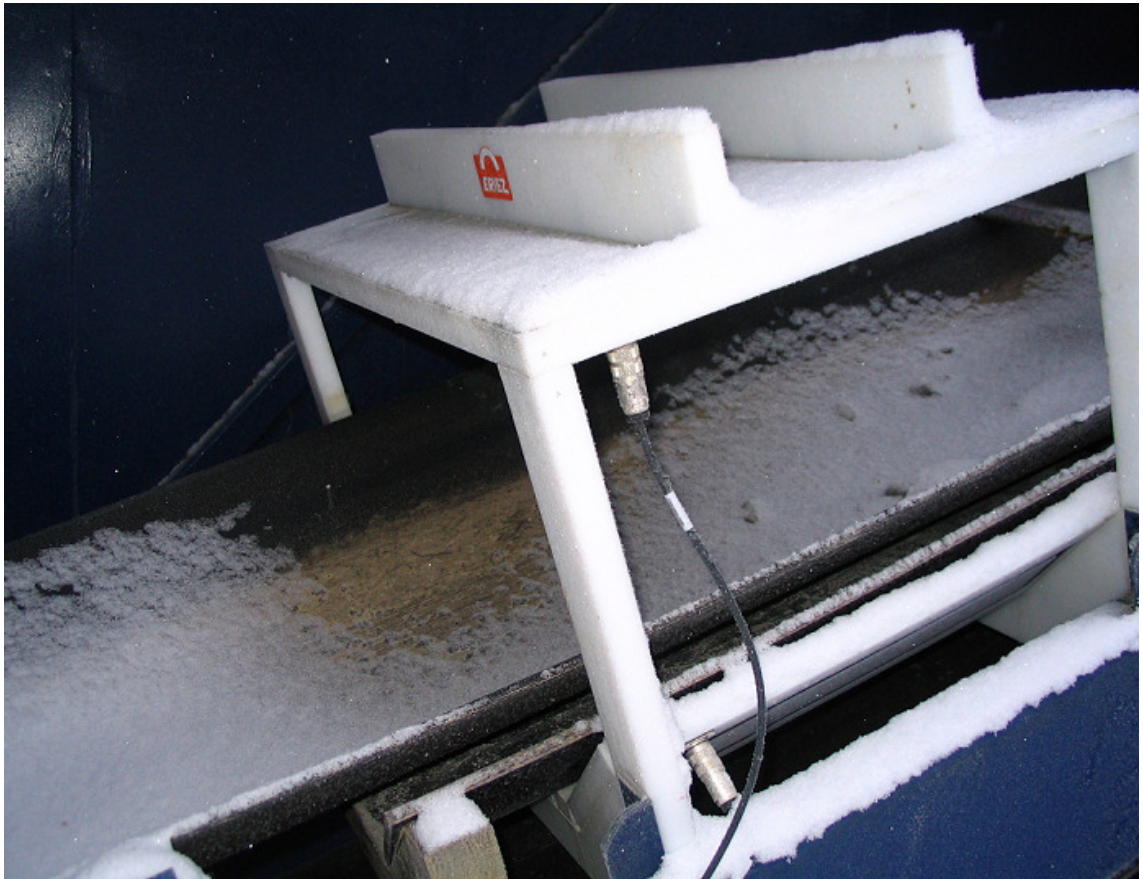
Kuva 11. Ensimmäisellä kuljetinhihnalla oleva metallinilmaisin asennettuna.
