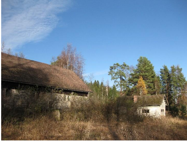
KUVIO 19. Vanhan rakennuskannan ympäristöt ovat huonokuntoisia
