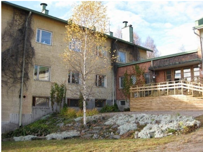
KUVIO 26. Paavali 1:n pääsisäänkäynnin edustalla on rinteessä istutuksia ja portaat. Sisäänkäynnille on rakennettu uudet, turvalliset portaat
