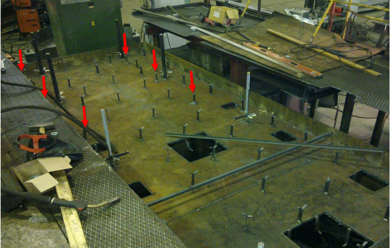
Kuva 6.1. Säteisporakoneen perustusmuotti. ➔ = Vanhat peruspultit
