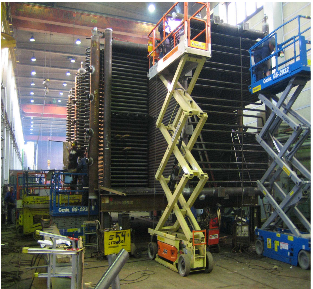
Kuva 3. 20 Mw:n voimalaituskattilan kokoonpanoa vuonna 2009. Kokoonpanoaika tässä tilassa 8 - 10 viikkoa. Kokonaistyöaika noin 14000 miestyötuntia ja 16 viikkoa.
