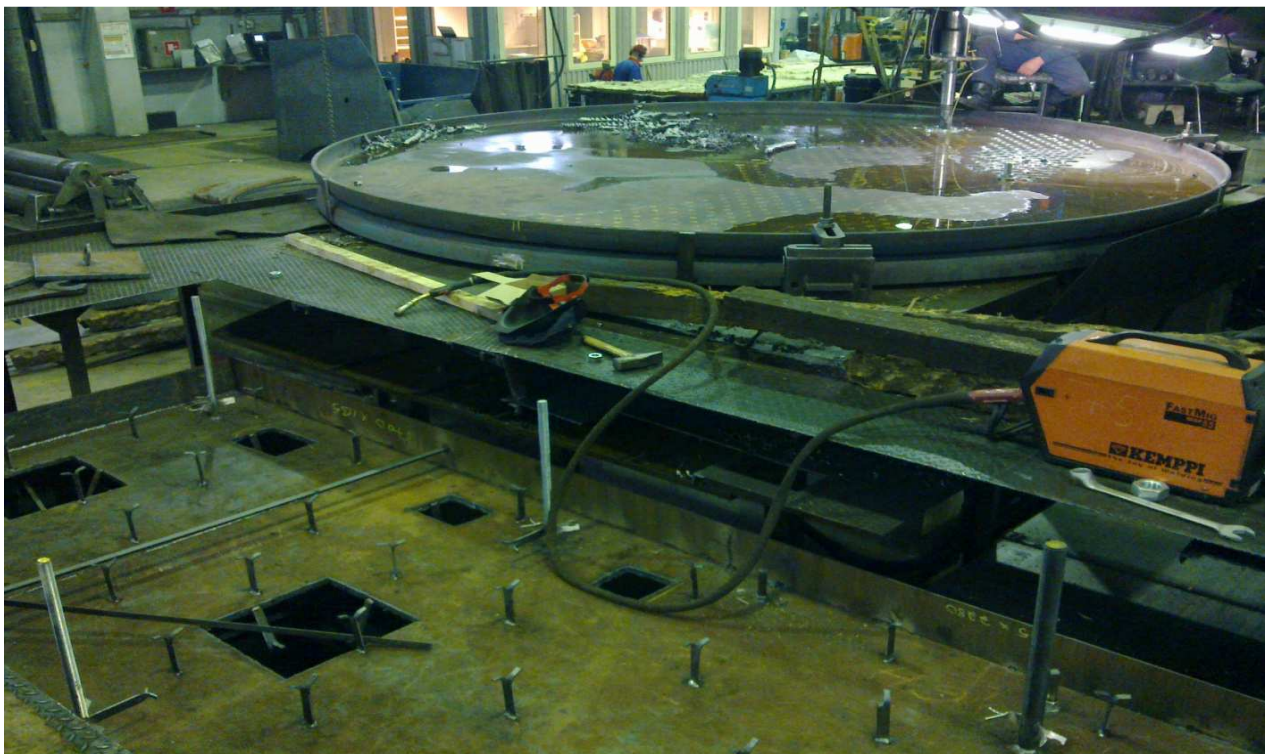
Kuva 6. Uuden säteisporakoneen paikka on vanhan vieressä.
