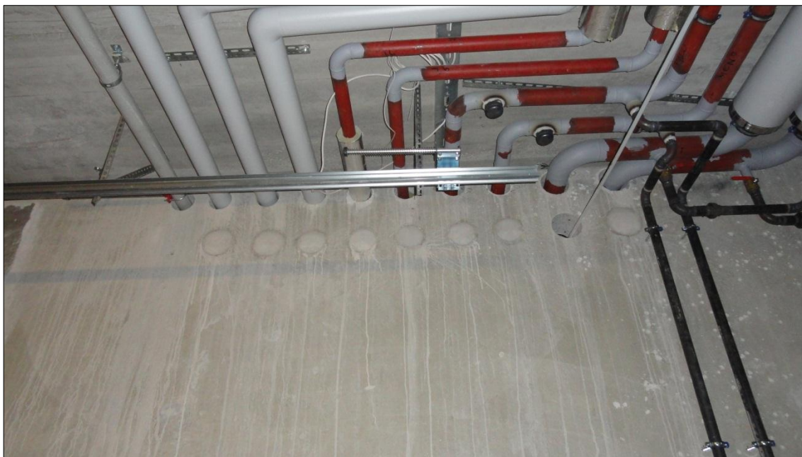
Kuva 7. Sivu-urakoitsijan läpiviennit olivat alunperin liian alhaalla nosto-oven takia.
