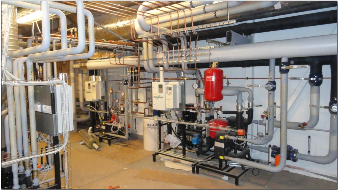
Kuva 3. Konehuoneen asennukset odottavat toimintakokeiden aloitusta.
