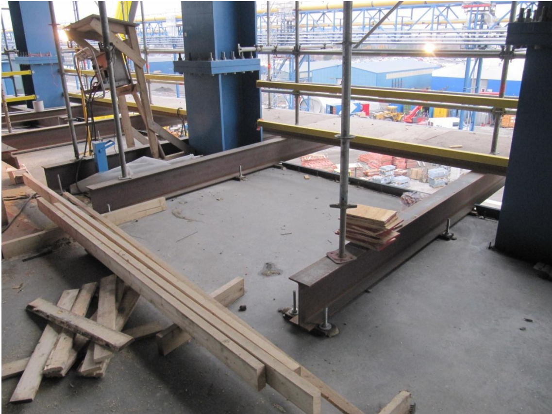
KUVA 3. Teräskonsolit paikoilleen asennettuina
