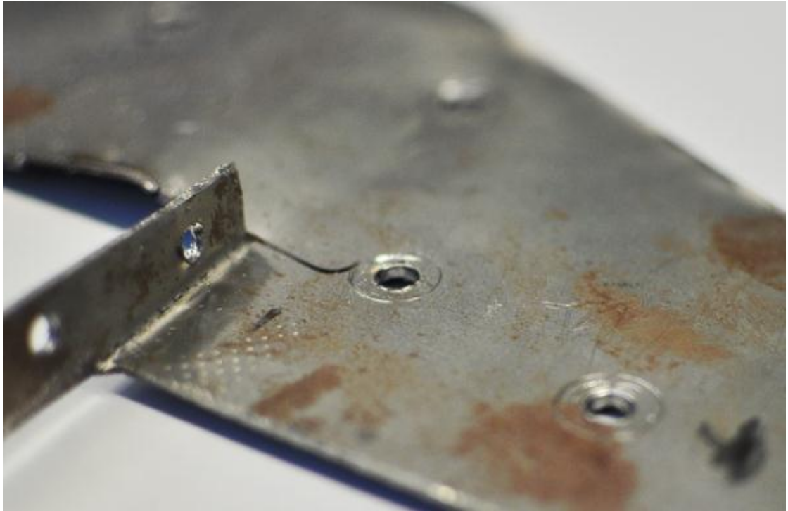
Kuva 64. Liitosten reikiin kohdistui myös suuria voimia, mutta ne pysyivät ennallaan.
