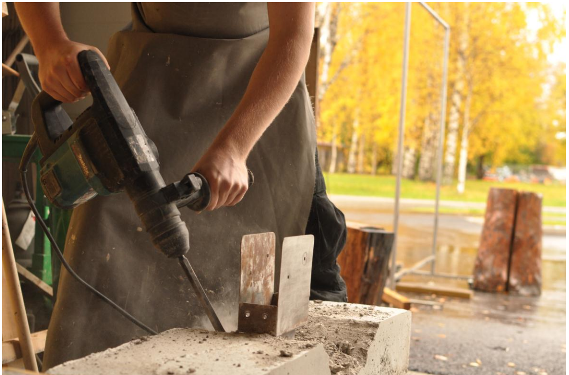
Kuva 22. Liitoksen irrotus betonista.
