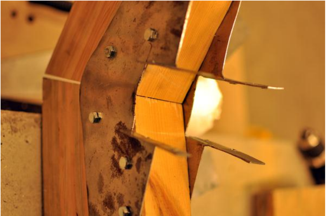
Kuva 60. Liitokset pysyivät hyvin paikallaan.
