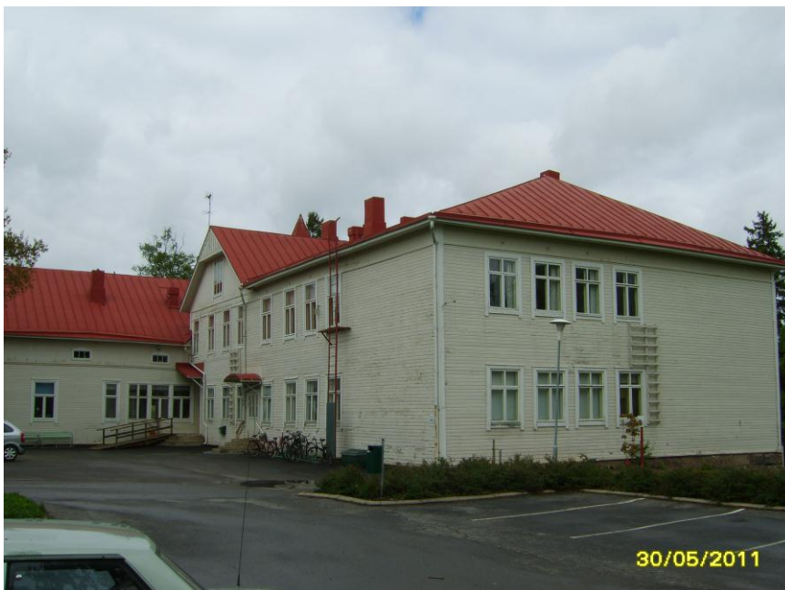
KUVA 1. Kokemäen kaupungin vanha yhteiskoulu, julkisivu kuva.
