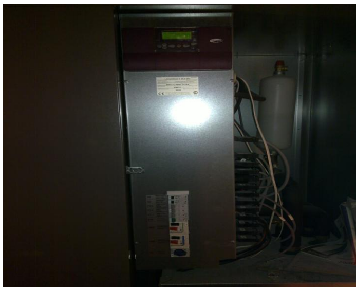
KUVA 21. Maalämpöpumppu Lämpöässä V20
