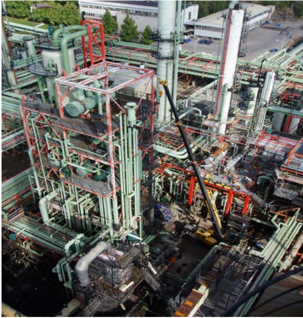
KUVIO 3. Seisokkityömaa 2006 (Kunnossapito 2006)
