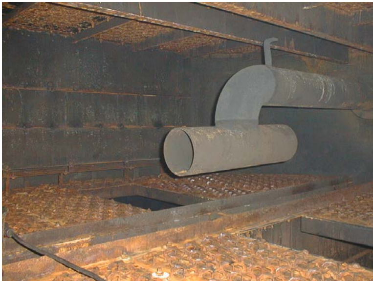
KUVIO 11. Kolonnin välipohjien tarkastus (Kunnossapito 2006)
