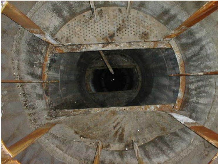
KUVIO 10. Kolonnin sisäpuolinen tarkastus (Kunnossapito 2006)
