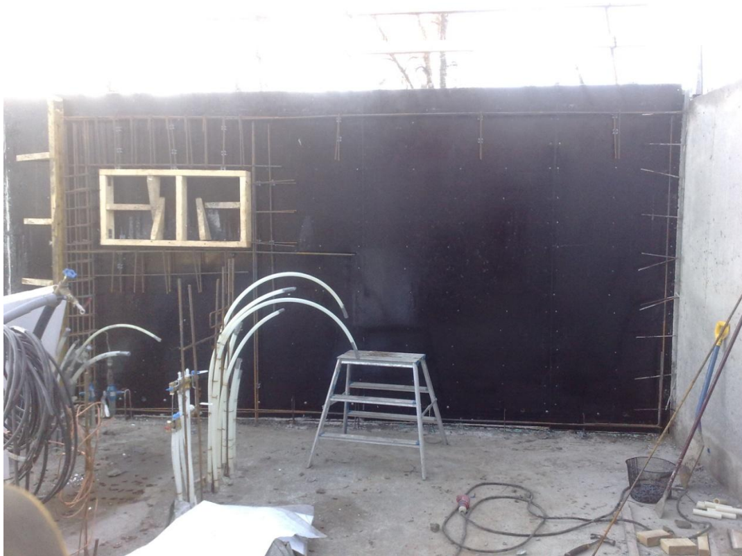
KUVA 12. Seinä raudoitettuna suunnitelmien mukaisesti
