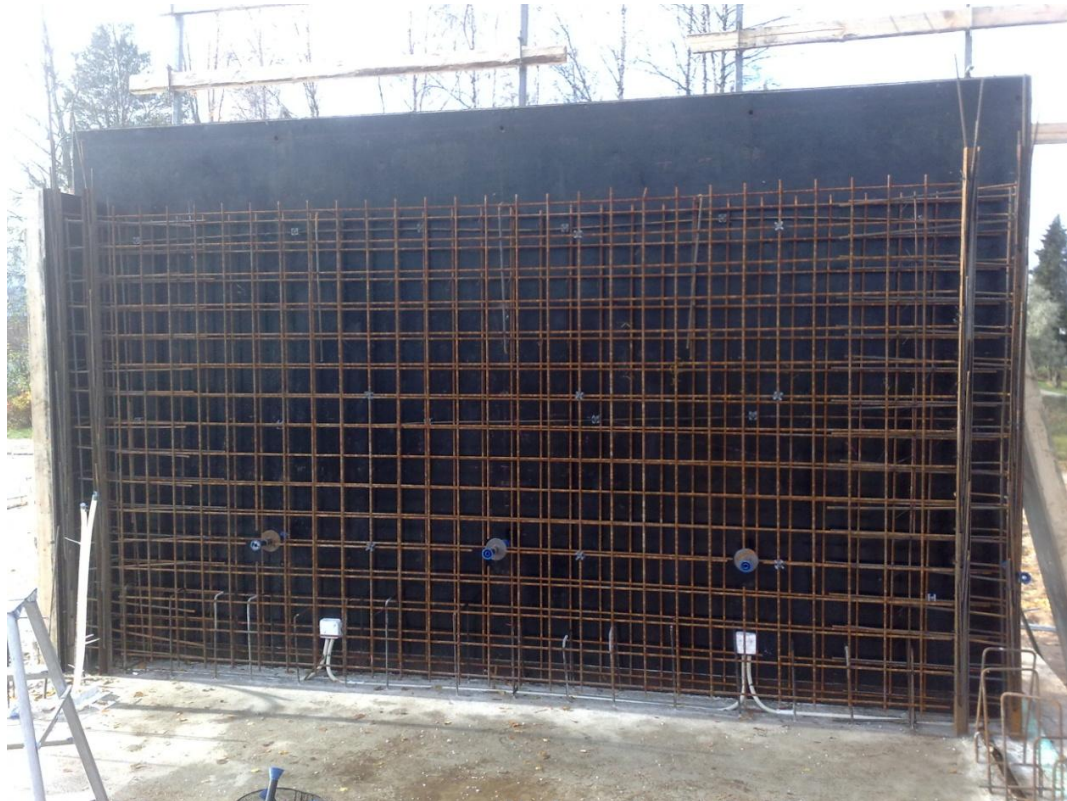
KUVA 13. Väestönsuojanseinä tuplausta vaille valmis
