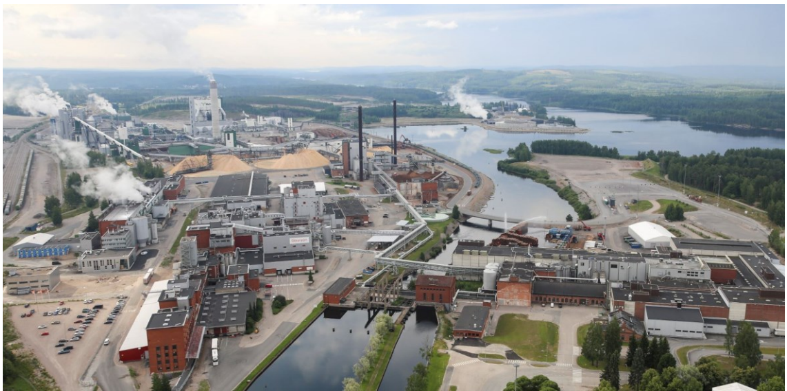
KUVA 1. Ilmakuva Äänekosken tehdasintegraatista: vasemmassa laidassa höyrypilven kohdalla sijaitsee tehtaan kartonkikonelinja ja virran oikealla puolella, rakennusten oikeassa laidassa tehdas arkittamo.
